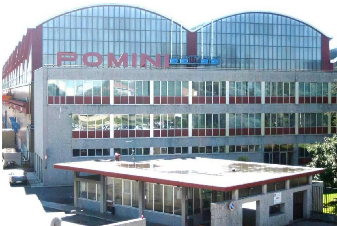
Fig. 1.1 – Vista esterna Pomini-Tenova S.p.A.
