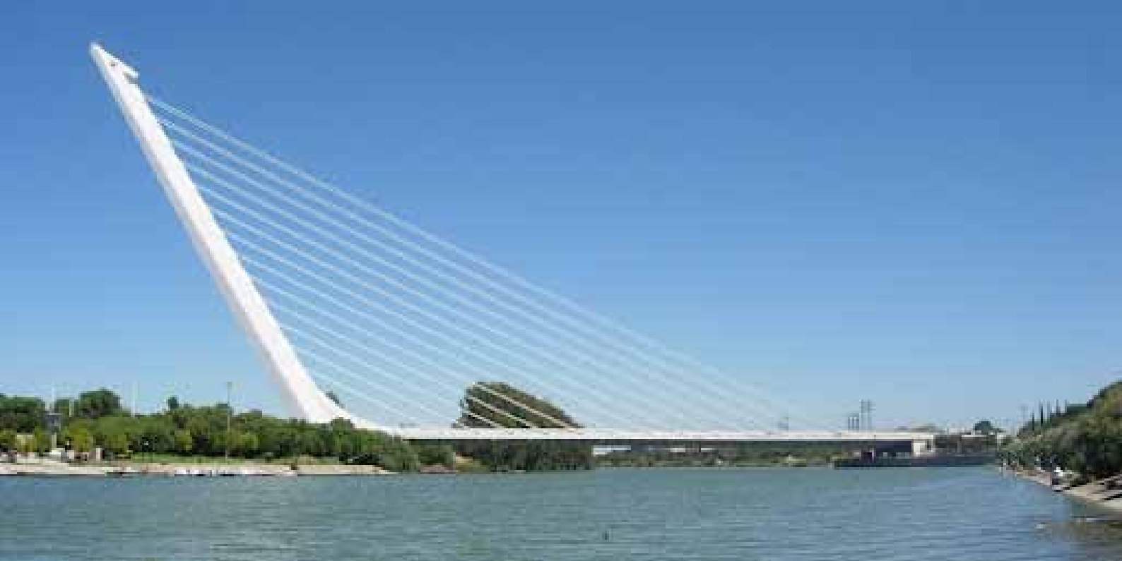
Fig.83. Il ponte Alamillo; Designer: Santiago Calatrava
