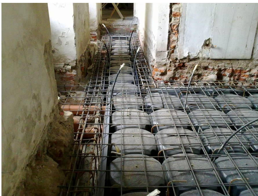
Figura 67 - Posa in opera della rete elettrosaldata
