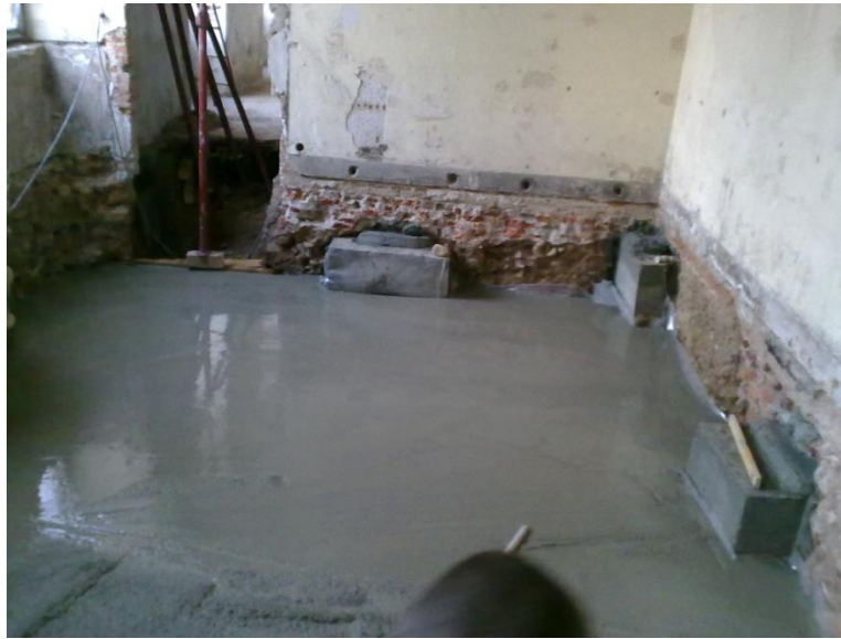
Figura 68 - Getto della seconda soletta in calcestruzzo armata con rete elettrosaldata
