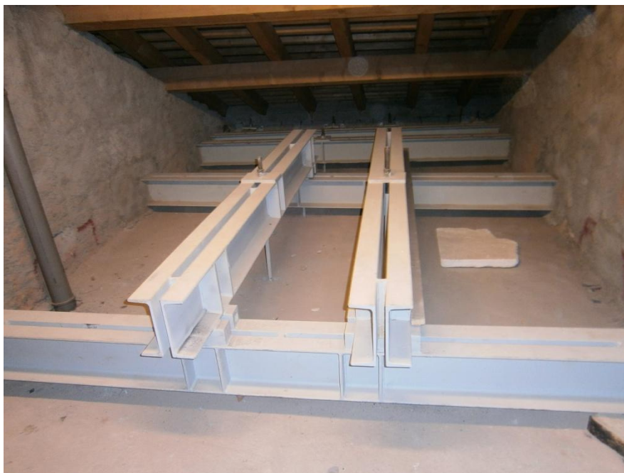
Figura 155 - Sottostruttura di sostegno della scala K, ubicata nel sottotetto
