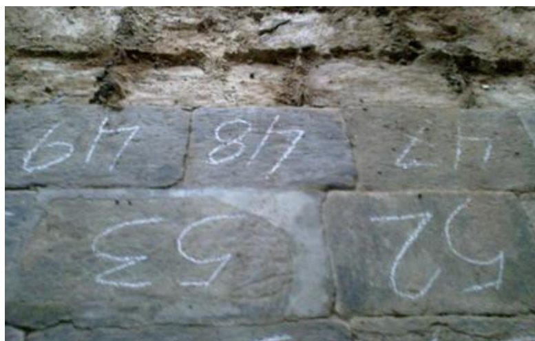
Figura 33 - Pavimentazione in lastre di pietra dell'atrio porticato
