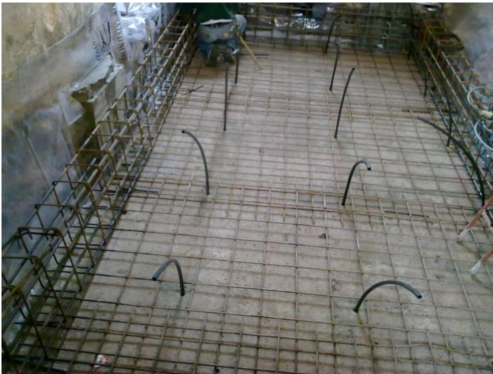
Figura 75 - Particolare dei tubicini di immissione della bentonite
