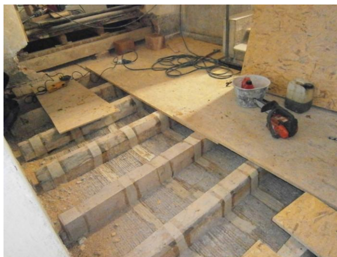
Figura 171 - Solaio a sbalzo dell'ambiente E2 al 1° piano
