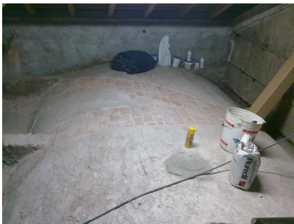
Figura 100 - Preparazione del supporto
