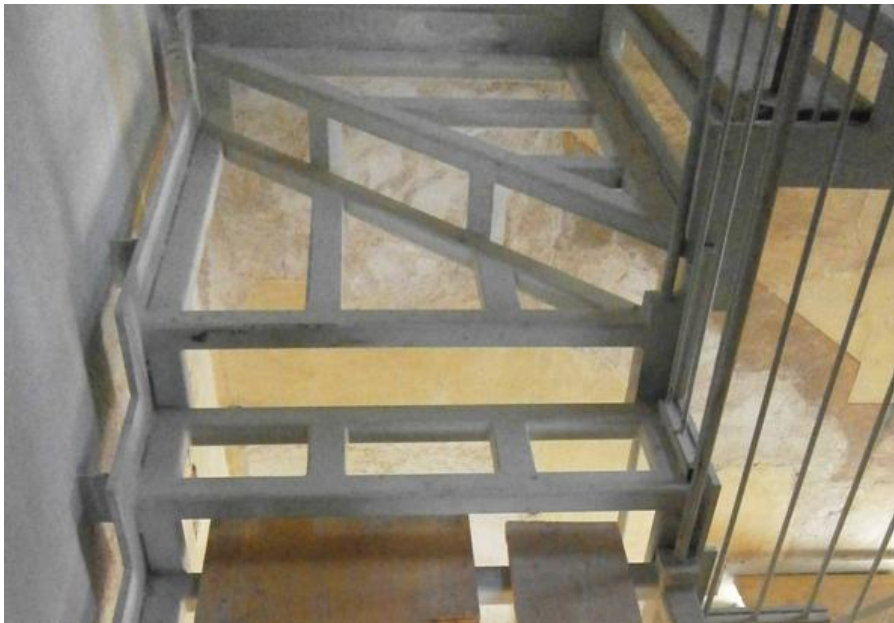
Figura 156 - Struttura portante dei gradini
