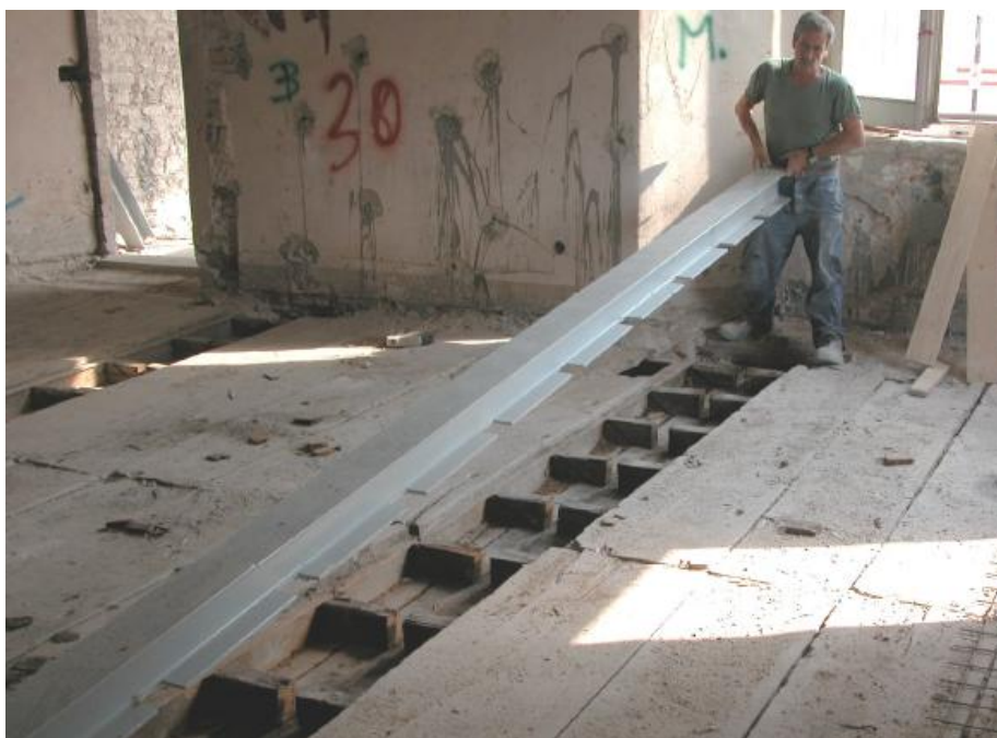
Figura 151 - Consolidamento delle travi con profili pultrusi incollati all'estradosso, Palazzo Collicola, Spoleto (PG)
