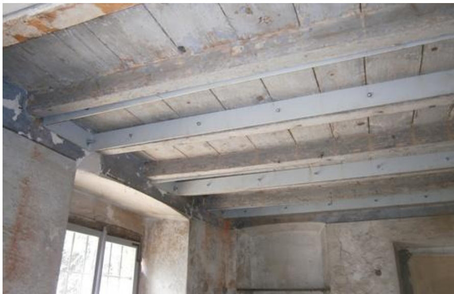
Figura 103 - Intervento con casseri metallici nel locale O1
