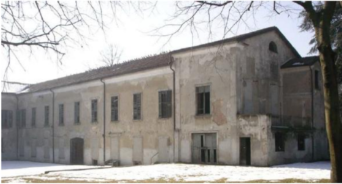
Figura 17 - Il prospetto ovest che da' sulla corte interna
