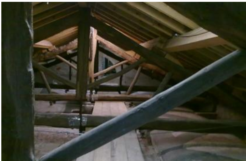
Figura 53 - Sottotetto corpo D
