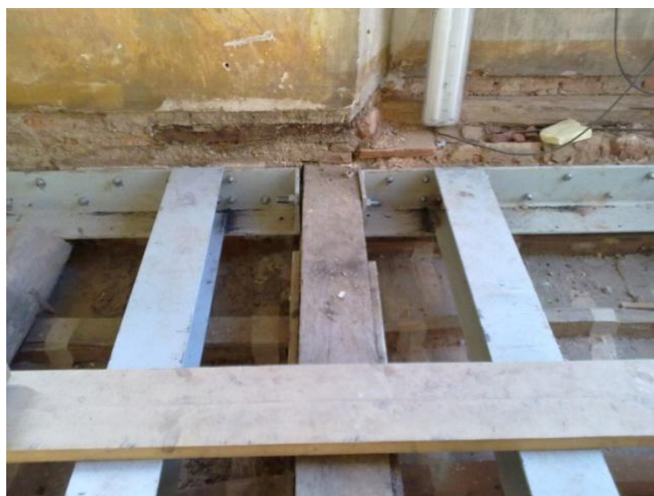
Figura 108 - Rinforzo del solaio ligneo mediante l'inserimento di profili metallici
