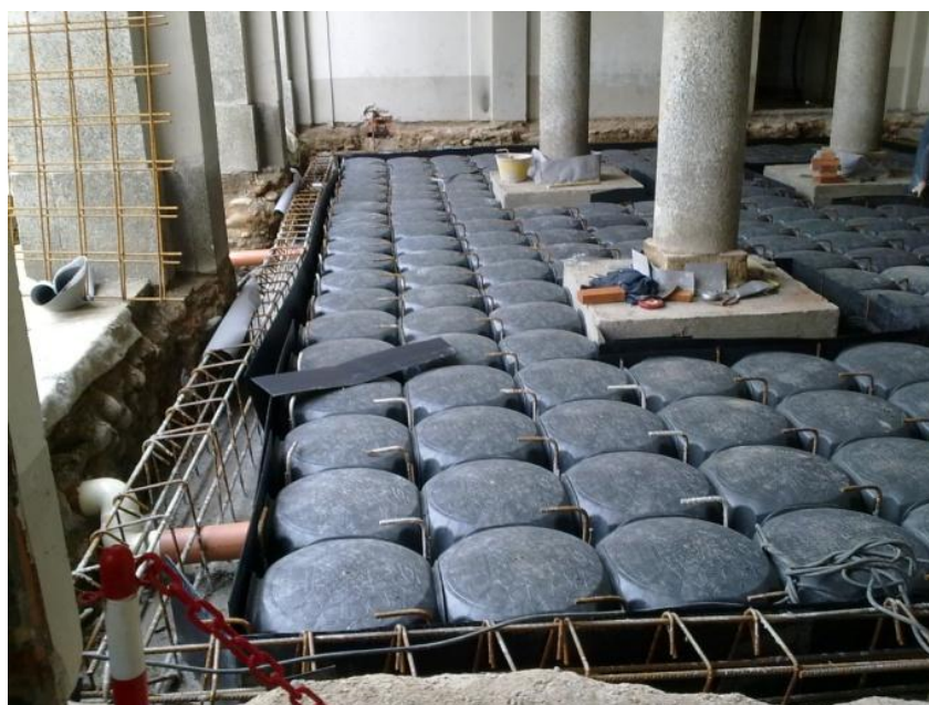
Figura 73 - Consolidamento delle fondazioni dell'atrio colonnato
