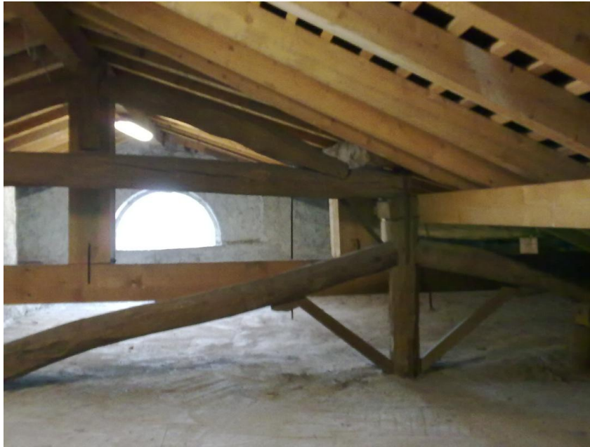
Figura 50 - Sottotetto corpo A
