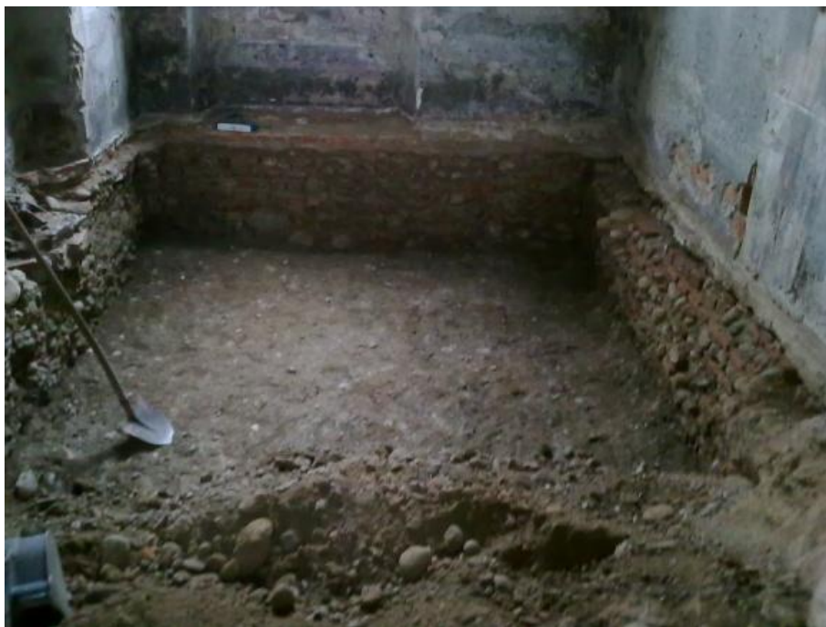
Figura 63 - Fondazioni esistenti in muratura
