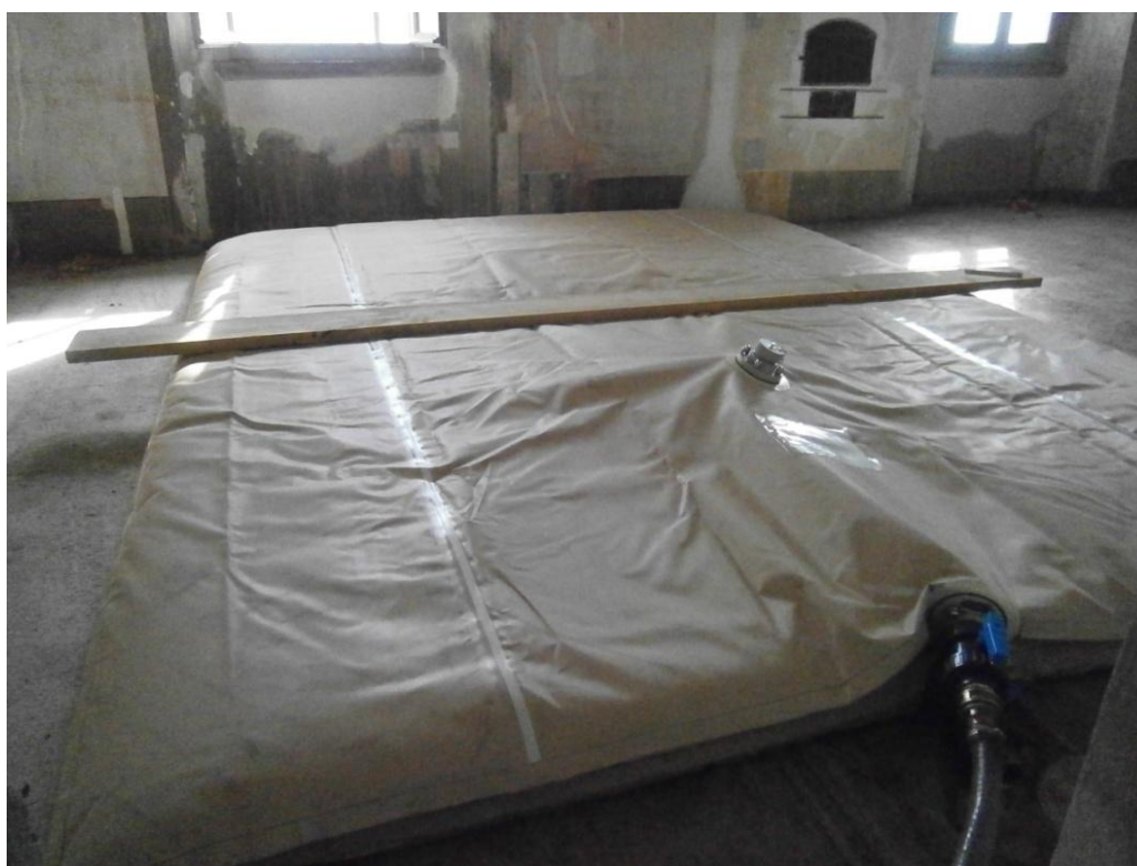
Figura 123 - Riempimento del primo serbatoio d'acqua
