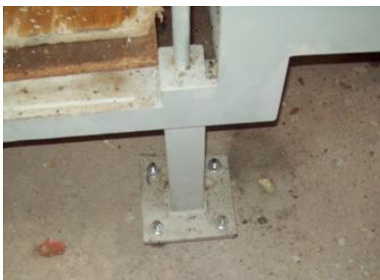
Figura 157 - Sistema di ancoraggio della scala a pavimento
