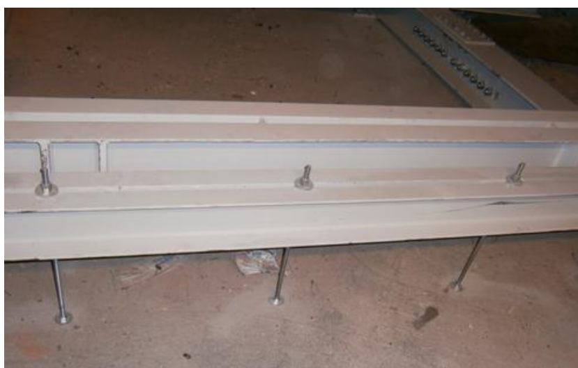
Figura 127 - Connettori fissati con dadi ai profili metallici posti nel sottotetto
