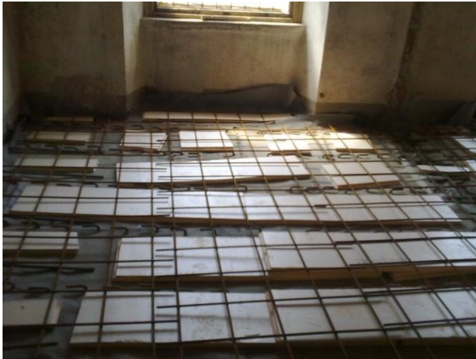
Figura 119 - Posa in opera degli elementi di alleggerimento e della rete elettrosaldata
