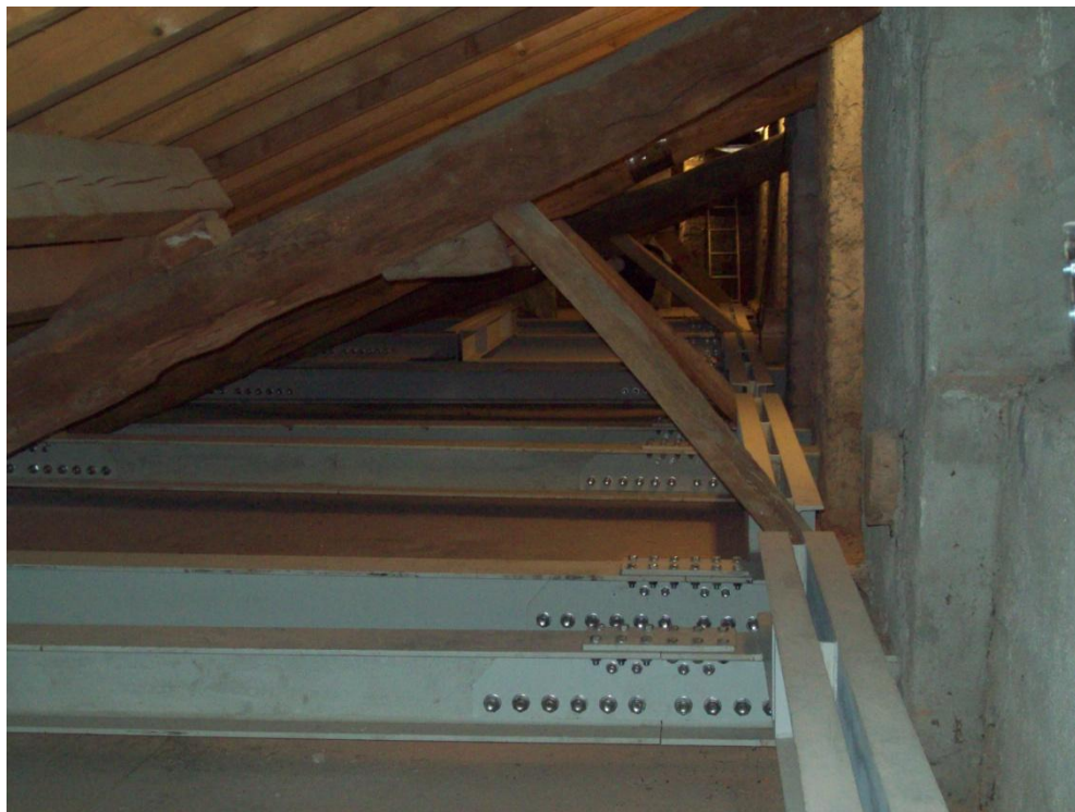
Figura 184 - Struttura di sostegno delle scale metalliche appese
