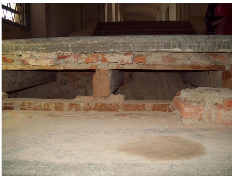
Figura 175 – Struttura portante dei gradini
