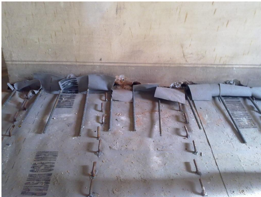
Figura 118 - Particolare dei connettori murari
