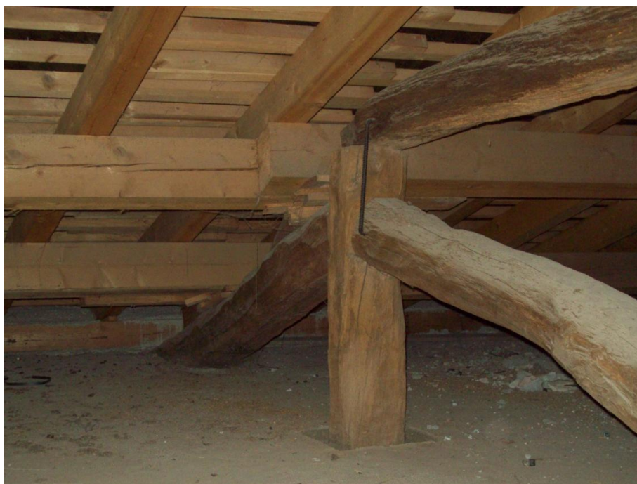
Figura 183 - Interventi di sostituzione o rinforzo degli elementi di copertura attuati nel 1999
