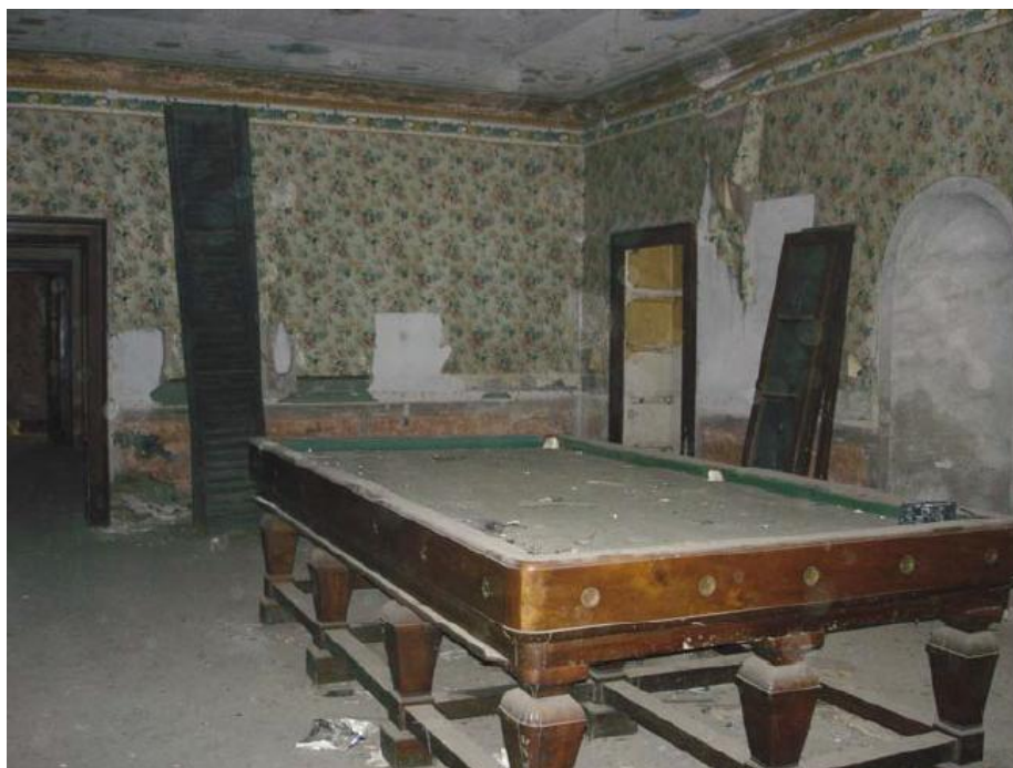
Figura 16 - La sala da biliardo al piano terra
