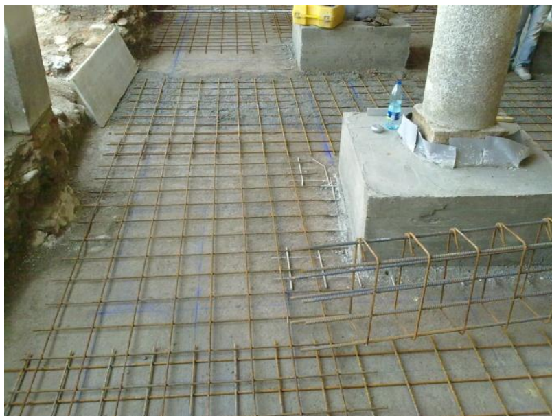
Figura 72 - Realizzazione del cordolo alla base della colonna
