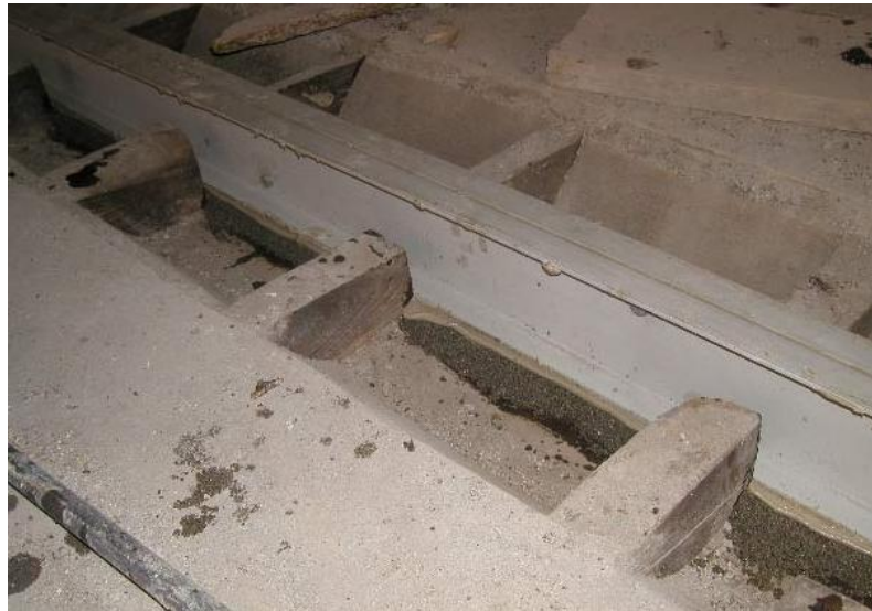
Figura 150 - Profilo pultruso in GFRP incollato all'estradosso della trave lignea mediante resina epossidica
