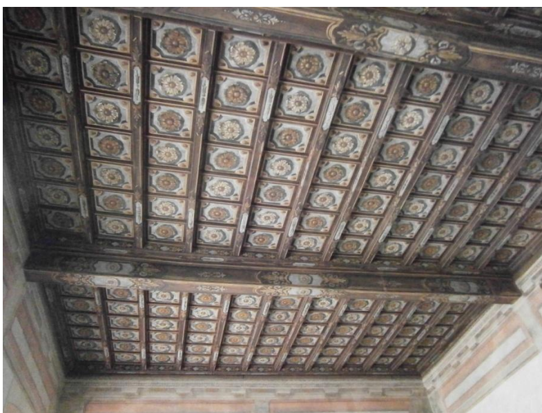
Figura 126 - Solaio in legno a cassettoni nel locale C al 1° piano
