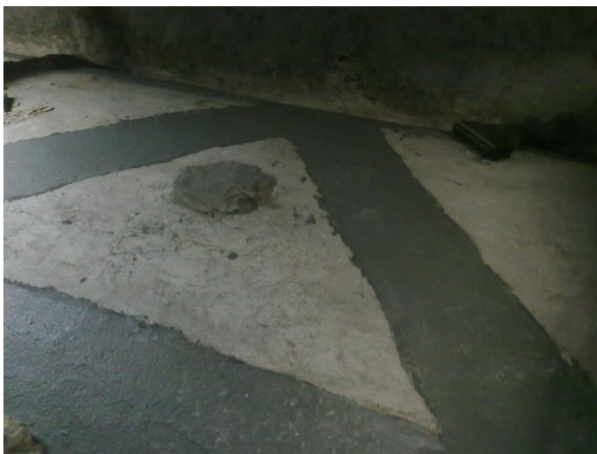
Figura 101 - Applicazione del rinforzo in CFRP
