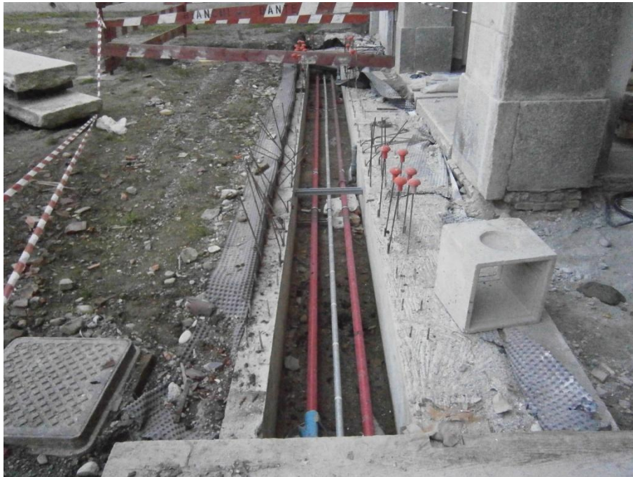
Figura 80 - Posa in opera dei canali impiantistici
