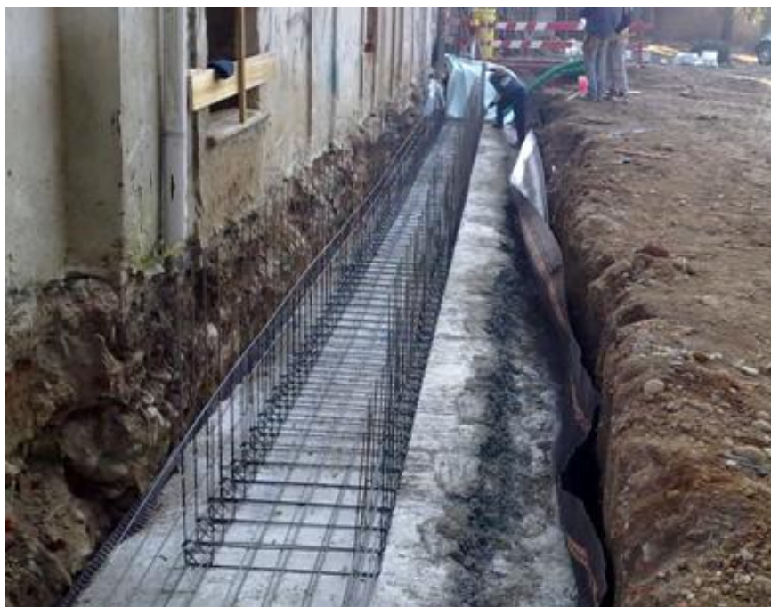
Figura 77 - Posa in opera dell'armatura
