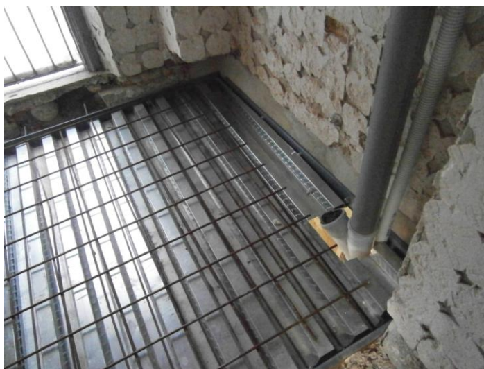
Figura 125 - Nuovo solaio in lamiera grecata
