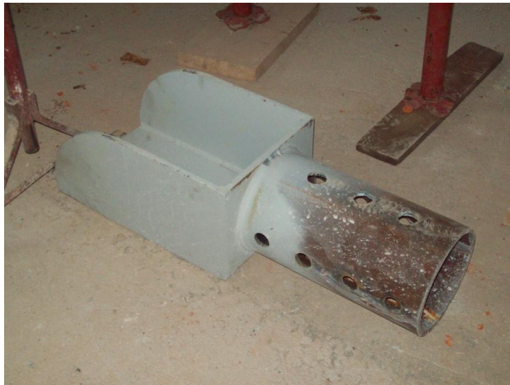
Figura 133 - Dispositivo a mensola per l'appoggio delle testate delle travi ammalorate
