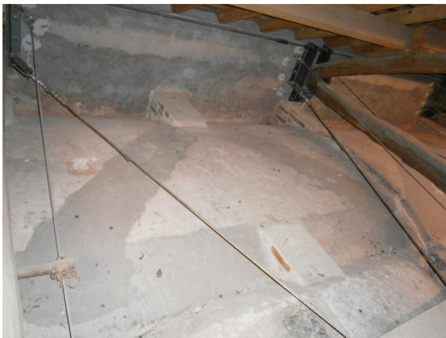
Figura 102 - Rinforzo volte in muratura con nastri in fibra di carbonio
