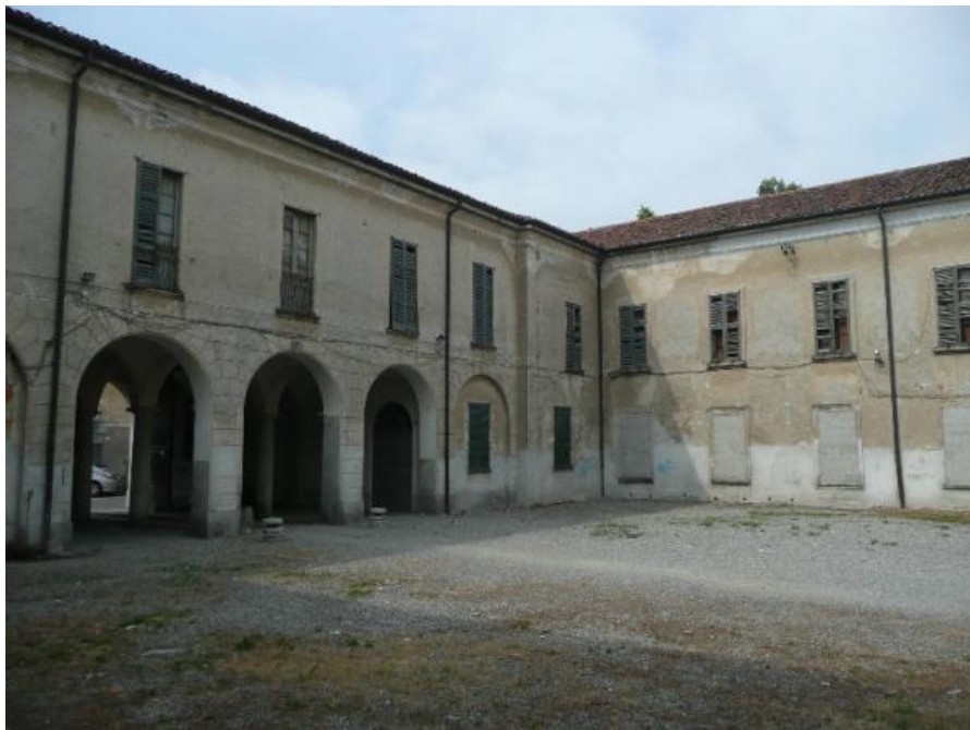
Figura 14 - Prospetto interno dell'ala sud
