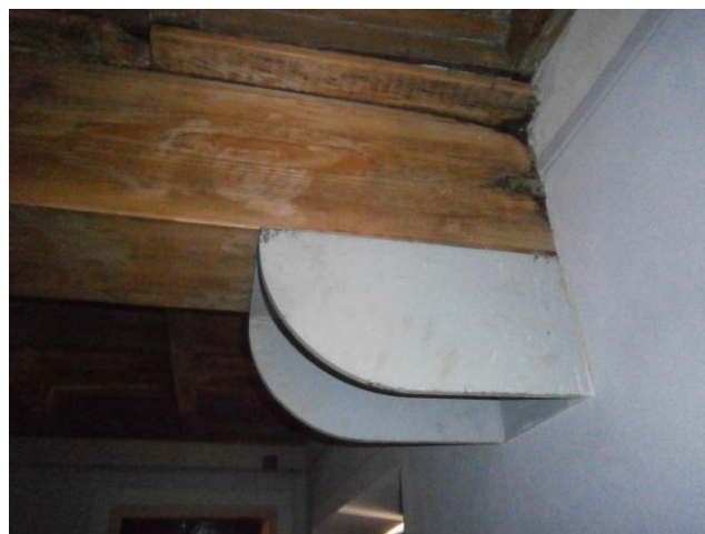
Figura 134 - Mensola metallica posta in opera nel locale E al piano ammezzato
