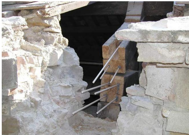
Figura 152 - Ricostruzione delle testate ammalorate di una capriata lignea
