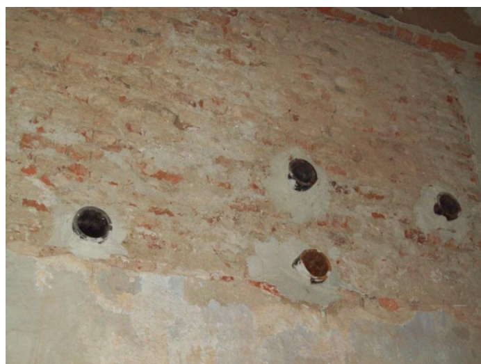
Figura 164 - Esecuzione dei fori nelle pareti per l'ancoraggio della scala
