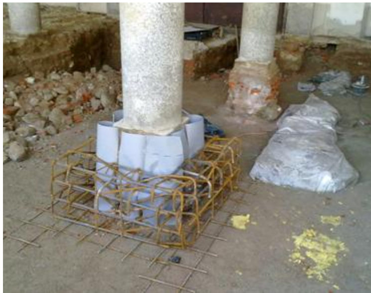
Figura 70 - Particolare dell'armatura del cordolo
