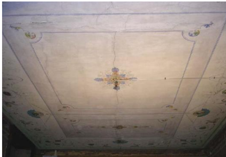
Figura 107 - Solaio con controsoffitto in canniccio nel locale L al piano terra
