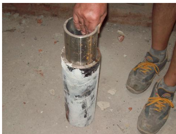
Figura 165 - Tubi in acciaio per l'ancoraggio della scala alla muratura portante
