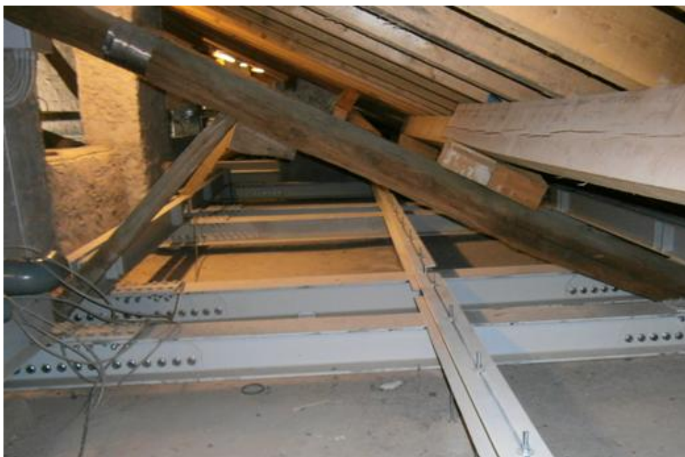
Figura 188 - Profili metallici posti nel sottotetto dell'ala ovest a cui verranno ancorati i tiranti
