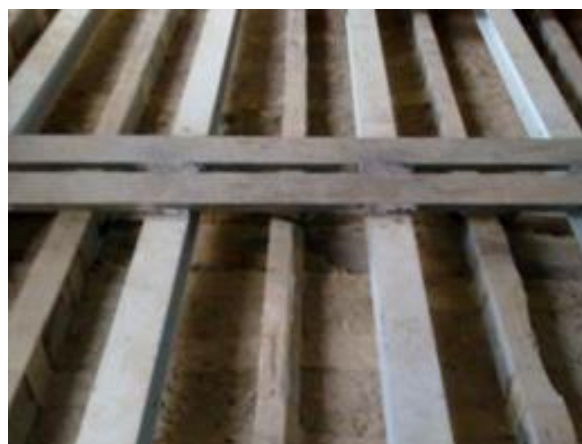
Figura 113 - Particolare delle due piastre metalliche costituenti il corrente superiore compresso
