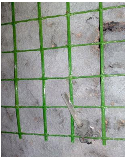
Figura 93 - Intonaco armato con rete in GFRP
