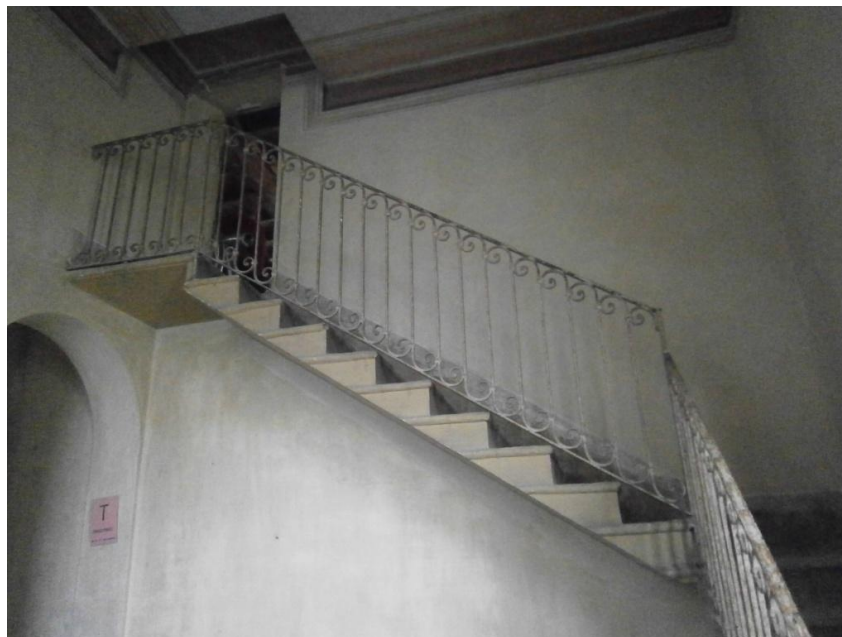
Figura 169 - Scaletta in pietra che conduce dal piano primo all'ammezzato
