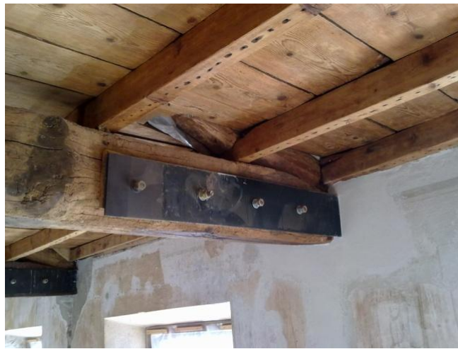
Figura 132 - Rinforzo degli appoggi mediante piastre in acciaio
