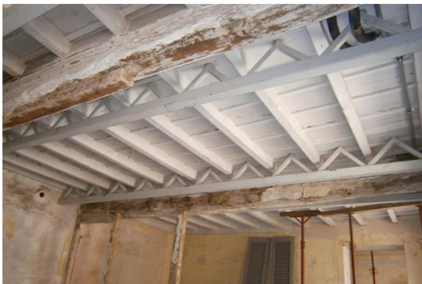
Figura 129 - Consolidamento delle travi principali nel locale P al piano terra
