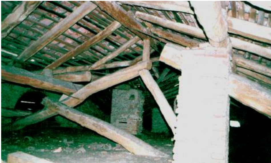
Figura 52 - Sottotetto corpo C
