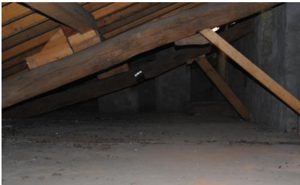
Figura 51 - Sottotetto corpo B
