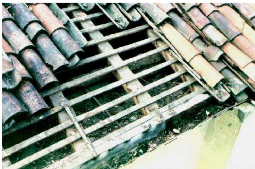
Figura 49 - Manto di copertura in coppi canale
