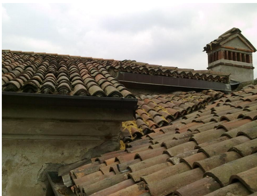
Figura 54 - Particolare del manto di copertura e della cornice di gronda
