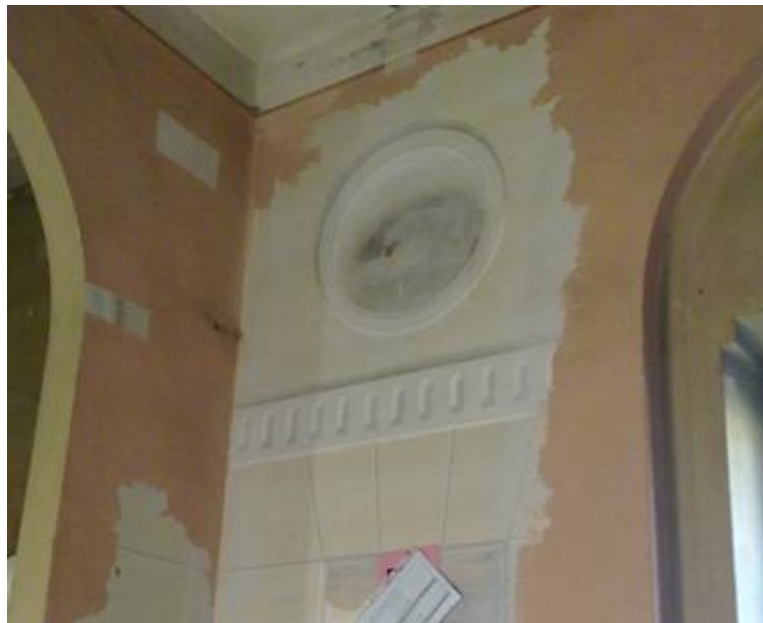
Figura 39 - Compresenza sulle pareti dell'atrio E3 al 1° piano di finiture appartenenti ad epoche diverse
