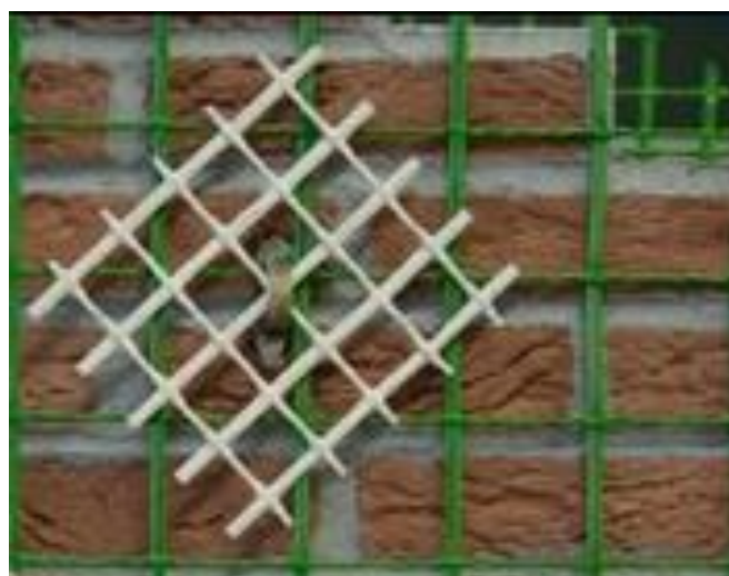
Figura 94 - Particolare della connessione tra rete e muratura
