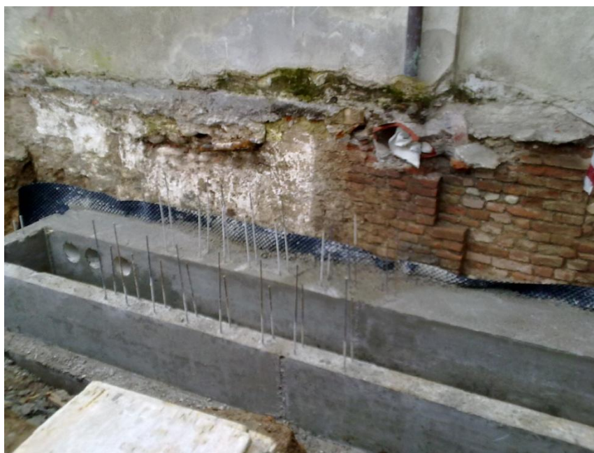
Figura 79 - Realizzazione del cunicolo impiantistico in c.a.
