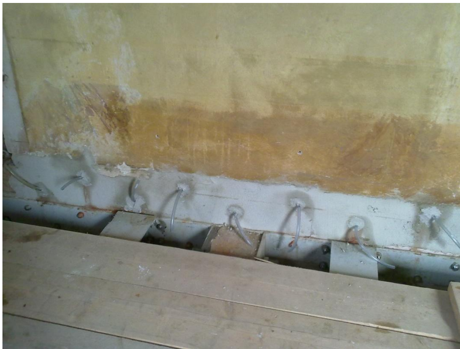
Figura 89 - Particolare dei bocchiglie per l'immissione della miscela
