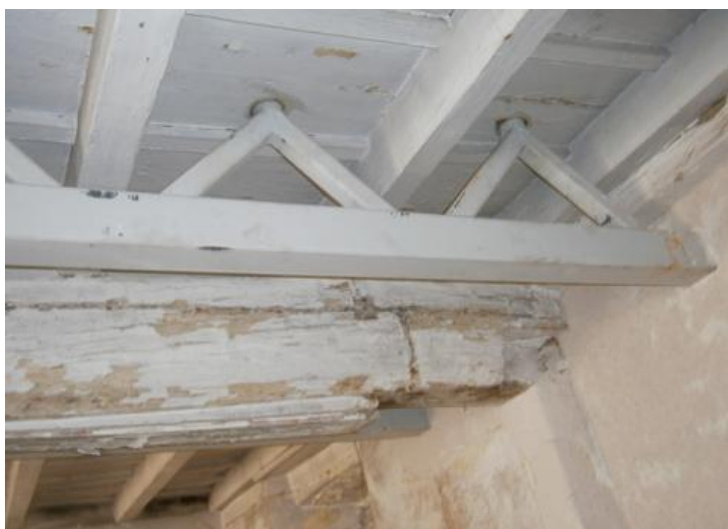
Figura 130 - Innesto della trave metallica nella muratura
