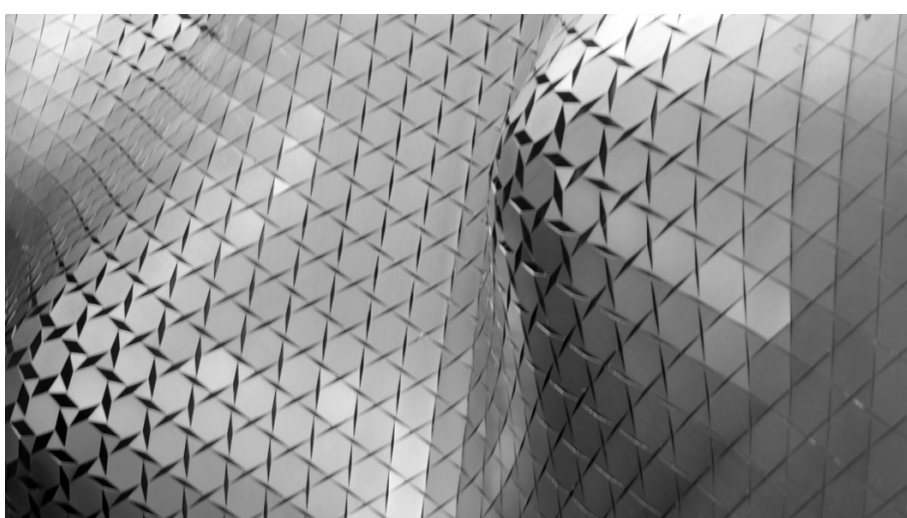
Figura 93: Geometria tridimensionale curva ottenuta da un foglio di materiale semi-rigido
