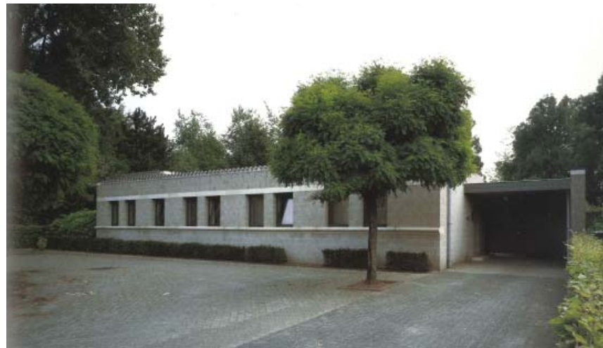
Figura 5.5.3 - Casa Naalden, ingresso
