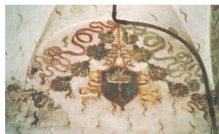
Fig. 7 | Camera del Crogiolo prima dei restauri. Lunetta, Impresa del candelabro.
