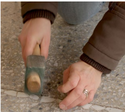
Fig. 40 | Posizionamento del chiodo topografico nella loggia.
