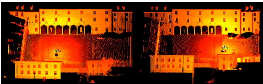
Fig. 22 | Nuvole di punti raffiguranti i fronti che si affacciano sul cortile interno del museo di San Sebastiano scansionate da due punti differenti con il laser scanner HDS 6000.
