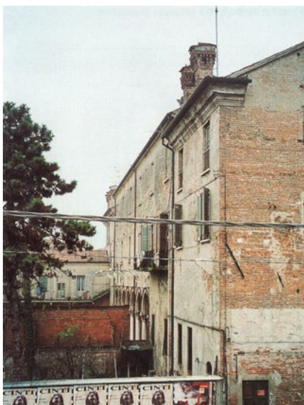
Fig. 11 | La torretta isolata dopo la demolizione di Porta Pusterla.
