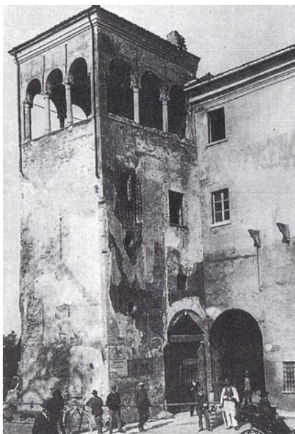
Fig. 10 | La torretta isolata dopo la demolizione di Porta Pusterla.
