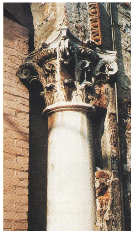
Fig. 3 | Loggiato del fronte settentrionale. Particolare prima dei restauri.
