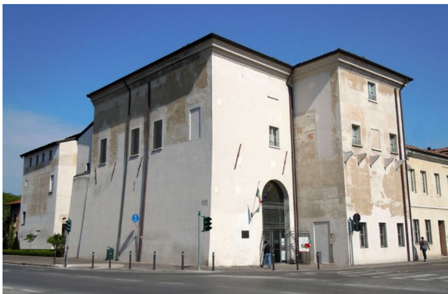
Fig. 13 | Stato attuale del Palazzo.
