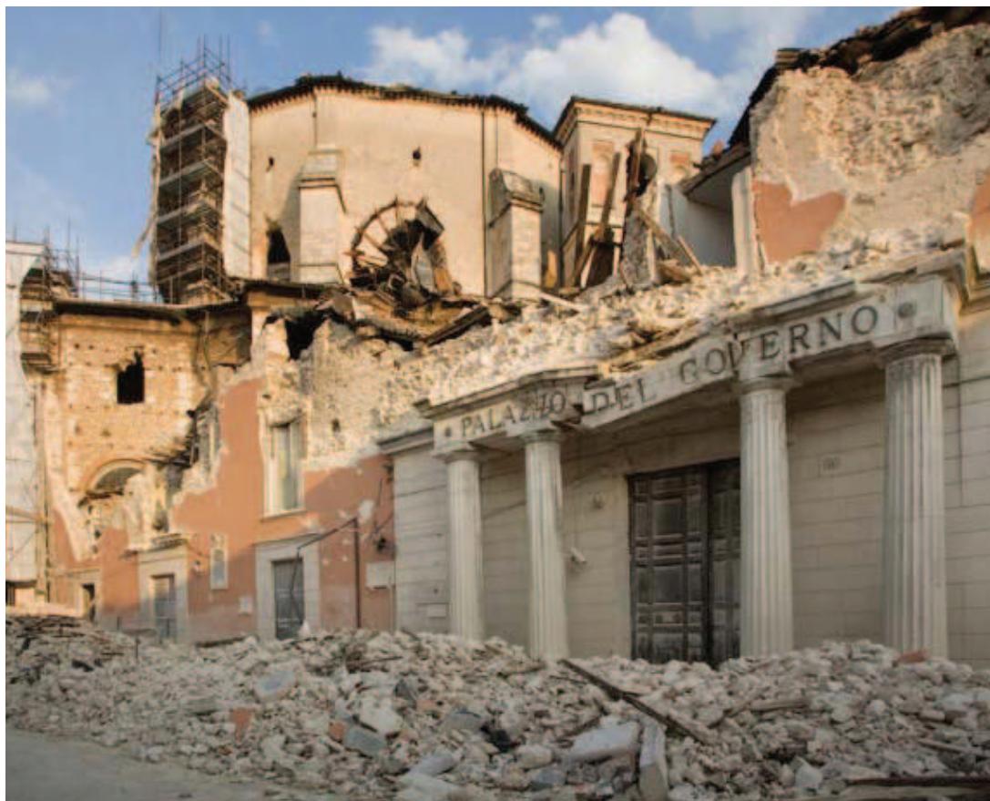
fig. 1.25_Il palazzo del governo ridotto in macerie dopo il terremoto.
