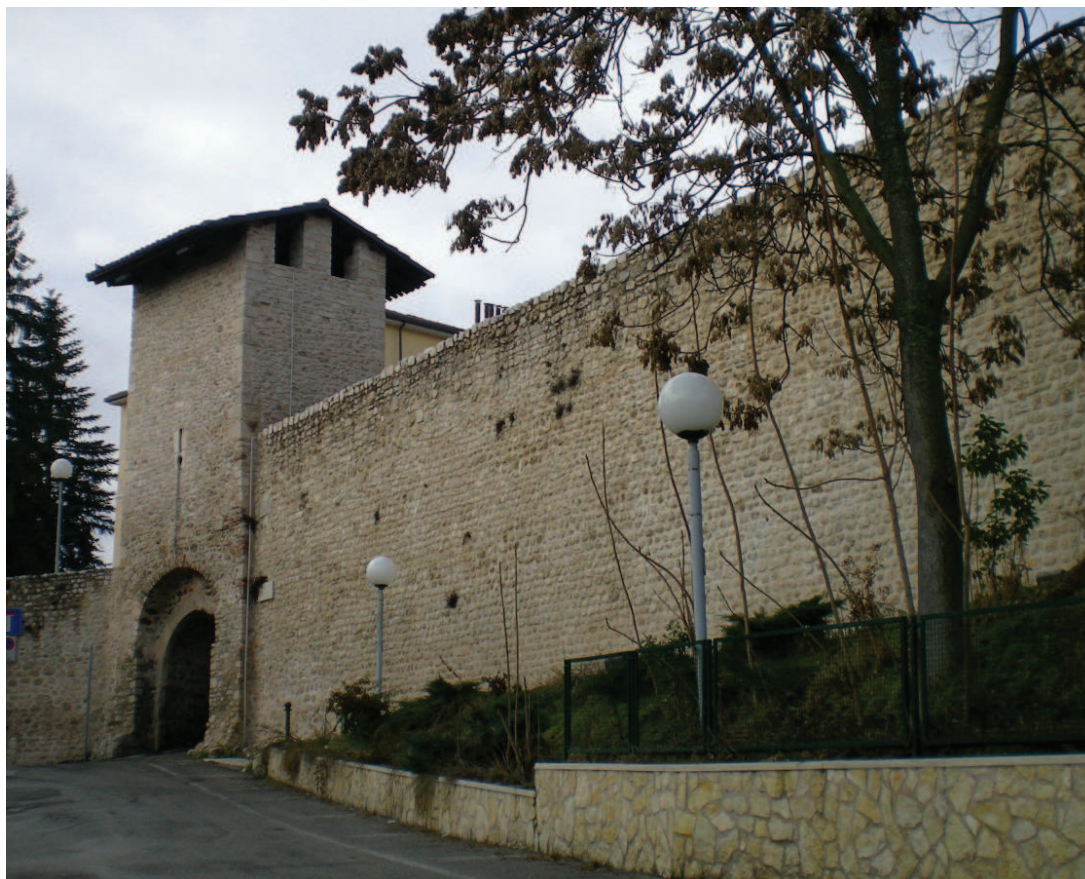
fig. 1.5_La cinta muraria nei pressi di Porta Leoni.
