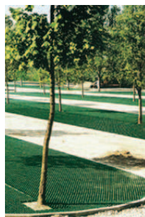
fig. 1.45 e fig. 46_Modulo Green Parking per la pavimentazione dei parcheggi.
