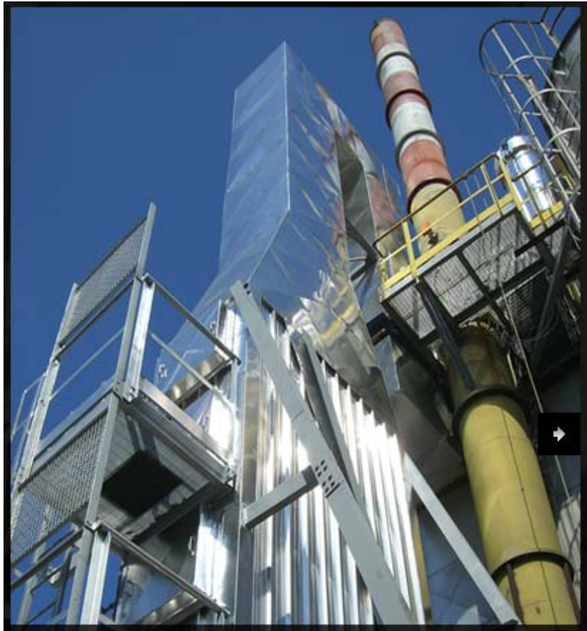
Figura 11 Sistema SCR applicato a un forno pre-esistente
