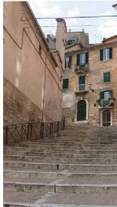
Fig.64 - Vista di via Anselmo Chiarizia 2
