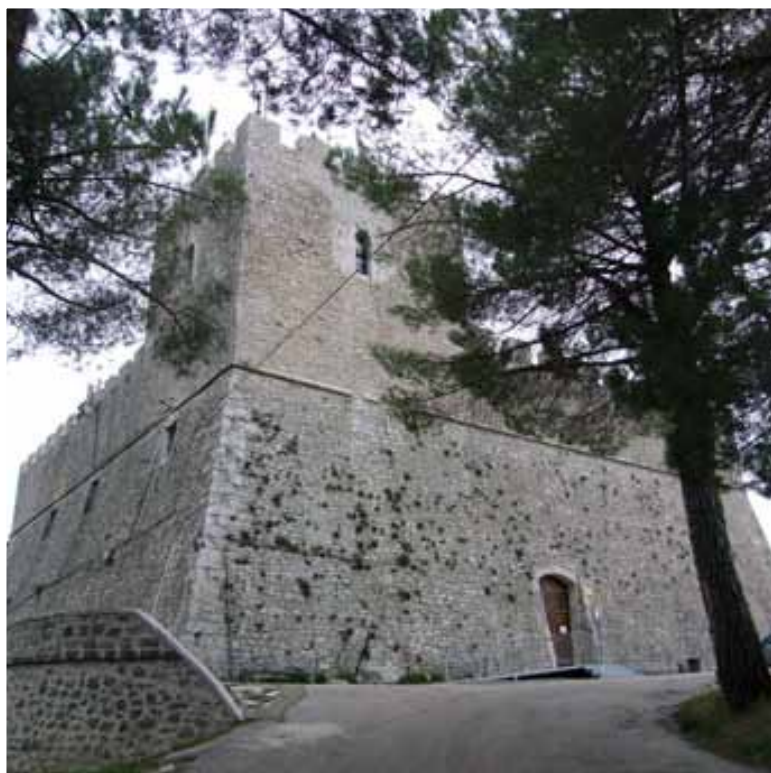
Fig. 67-72 - Viste del Castello Monforte
