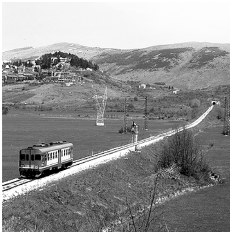
Fig.2 - Vista della tratta ferroviaria Vairano - Isernia - Campobasso - Larino
