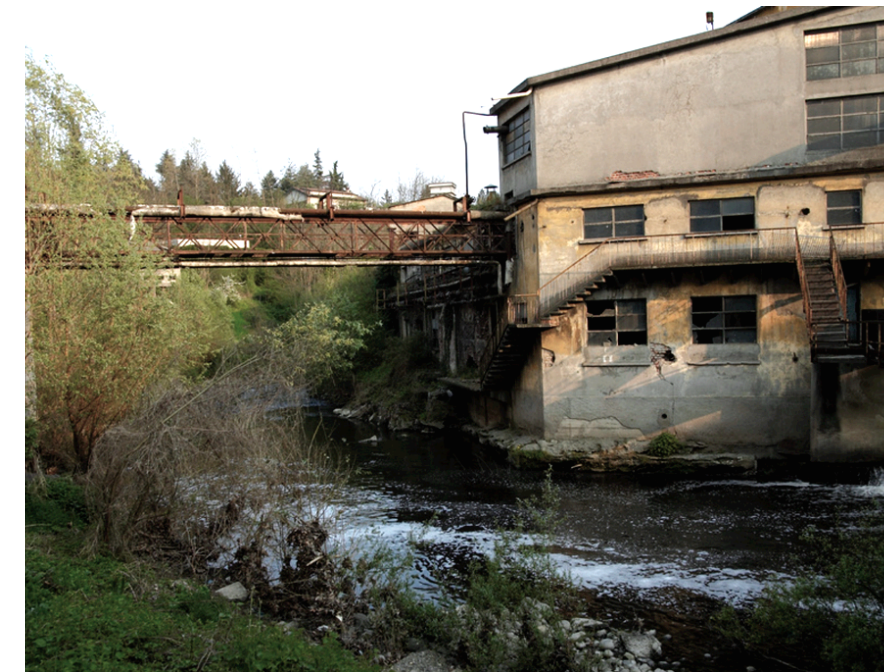
Ex cartiera villa, vista sul fiume Lambro
