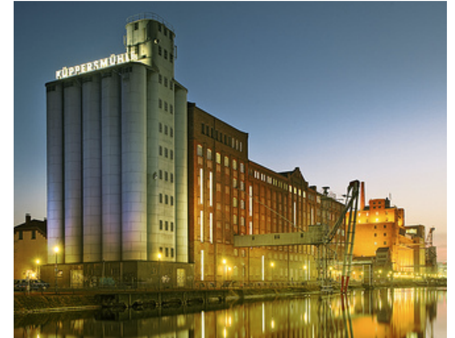
Riqualificazione di un edificio con mulino a Duisburg
