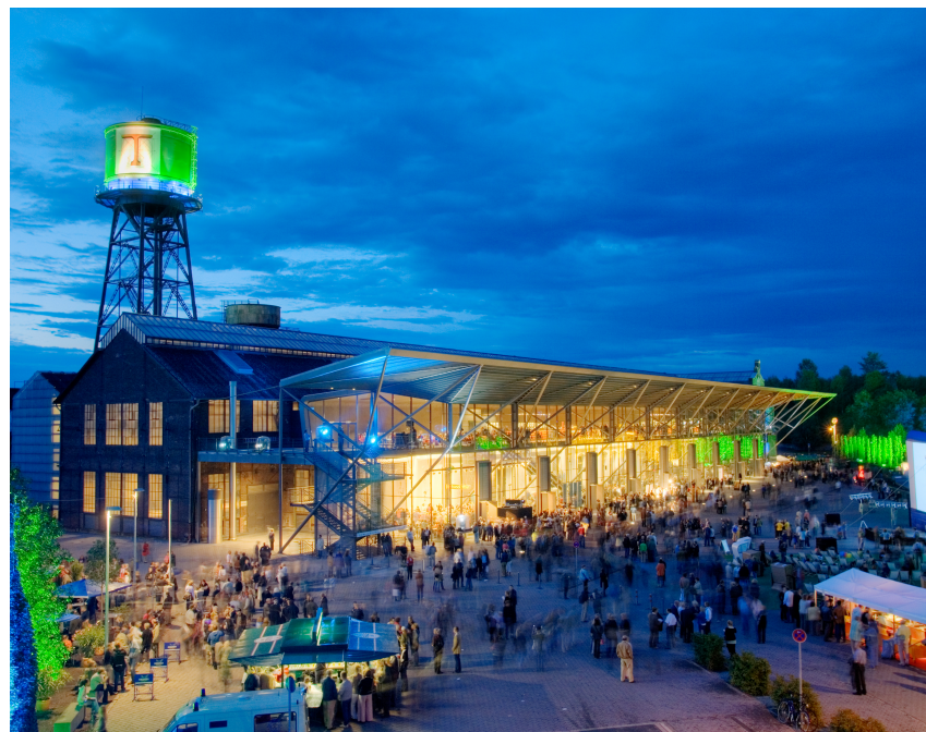
Riqualificazione di un edificio a Bochum
