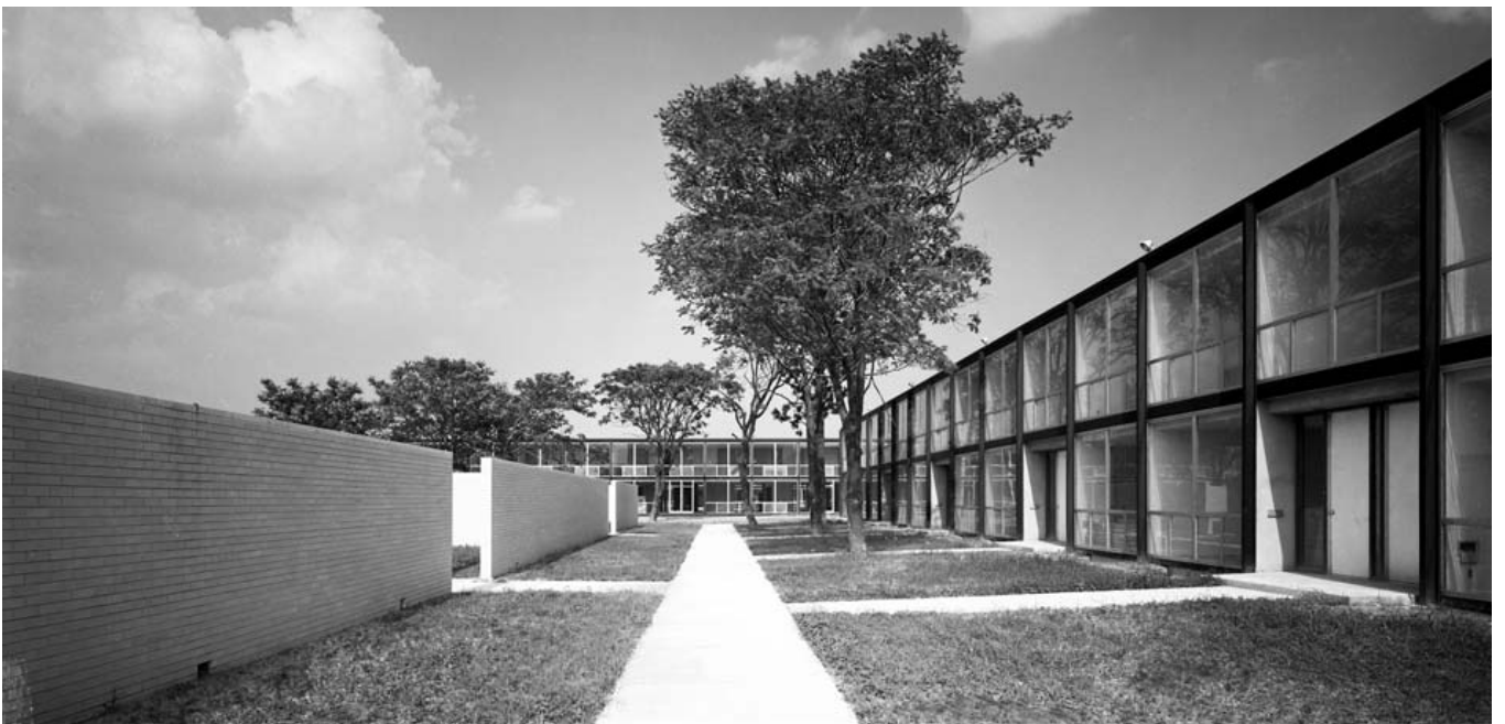
Figura 34- La Fayette Park, Case a due piani, Ludwig Mies van der Rohe, Detroit-Michigan, USA, 1963
