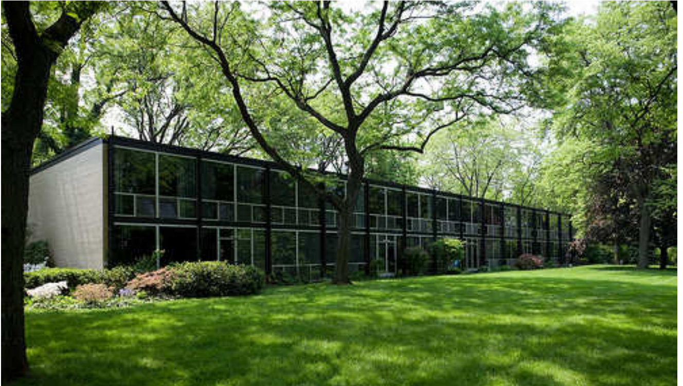
Figura 33- La Fayette Park, Case a due piani, Ludwig Mies van der Rohe, Detroit-Michigan, USA, 1963
