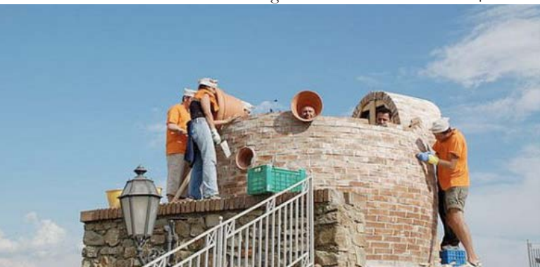
Figura 80. Costruzione della cupola di Cairano.
