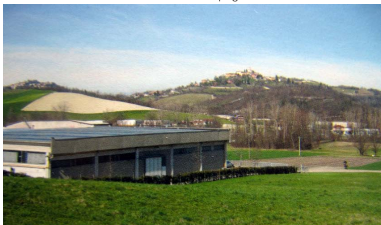
Figura 64. Uno dei capannoni costruiti nelle campagne del Monferrato Casalese.
