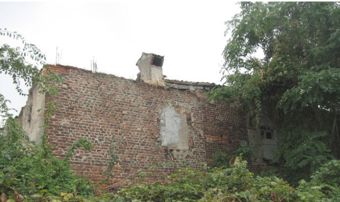
via Boffalora 75 parco Agricolo Sud
