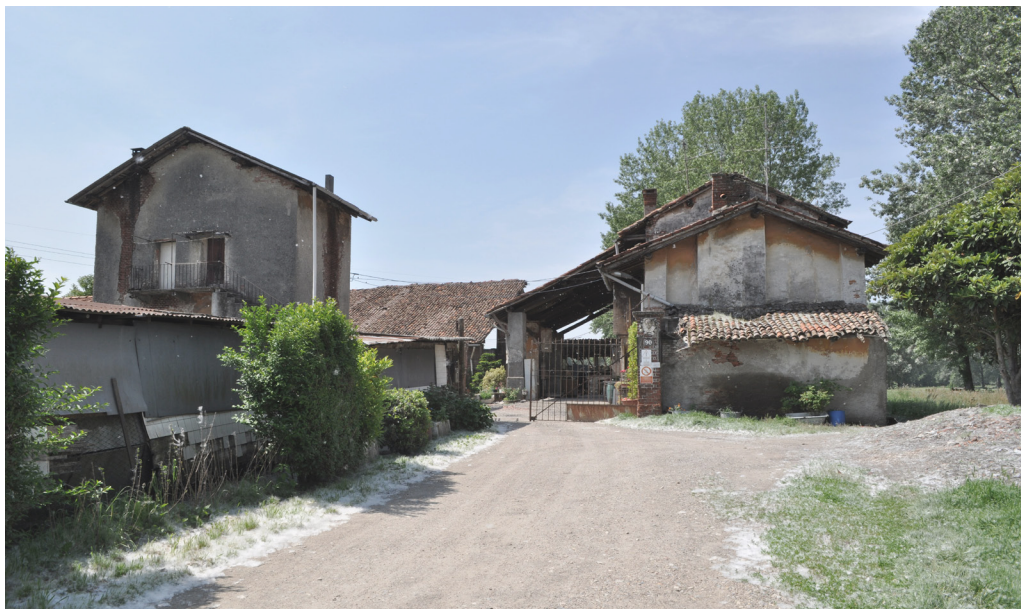
Ingresso al cortile
