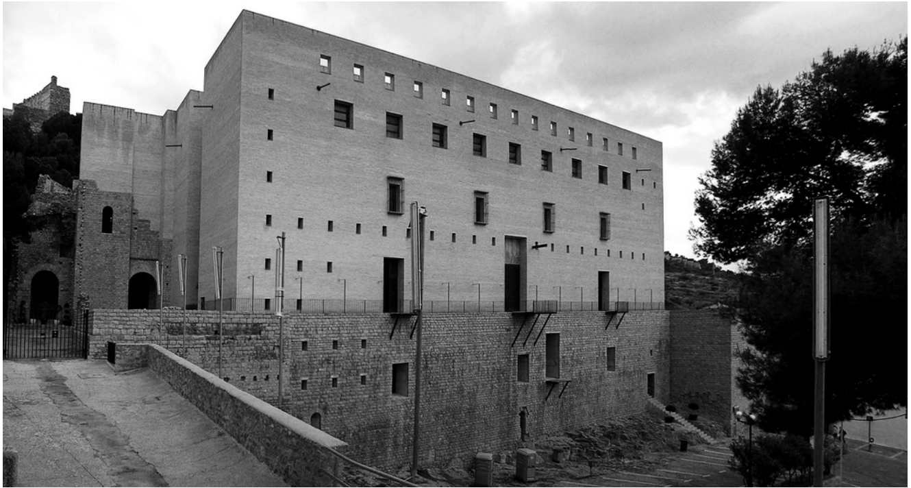
Restituzione del muro di postscaenium
