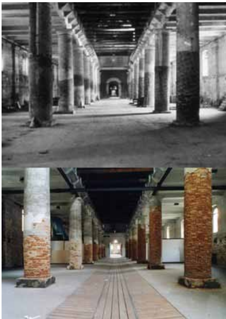
40. Arsenale Venezia, prima e dopo gli interventi di restauro
