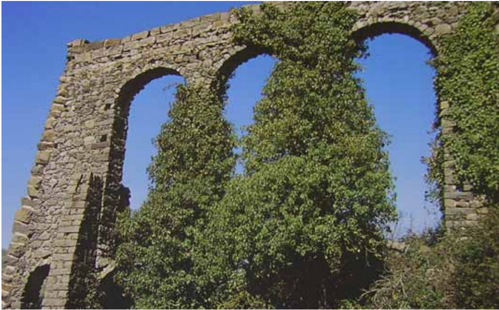
12. Resti di acquedotto a contrada Bilingeri
