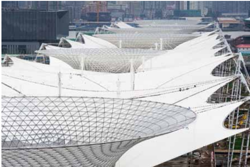
72. Vista dall'alto della copertura
