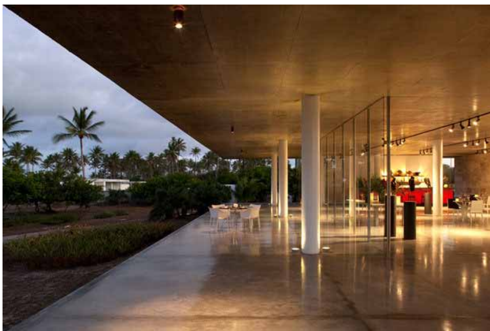
97. Porticato di fronte alla hall
