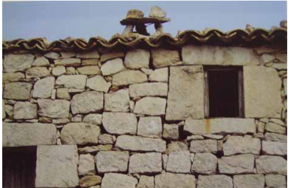
13. Esempio di costruzione a secco in contrada Poggio Grosso
