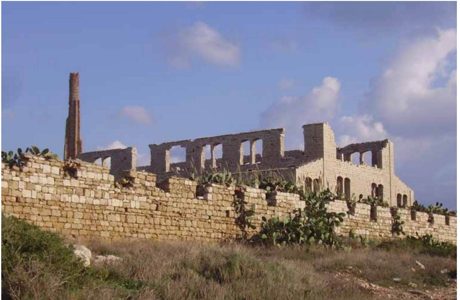
14. Ex- Fornace Penna, prospetto fronte mare
