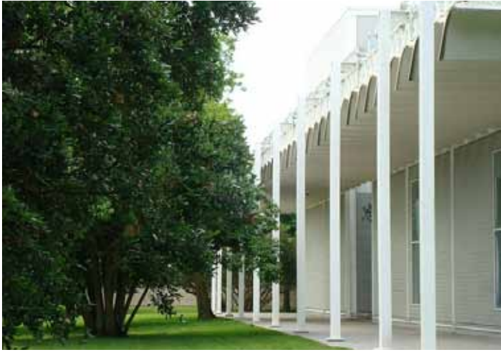
53. vista del porticato sul lato dell' ingresso
