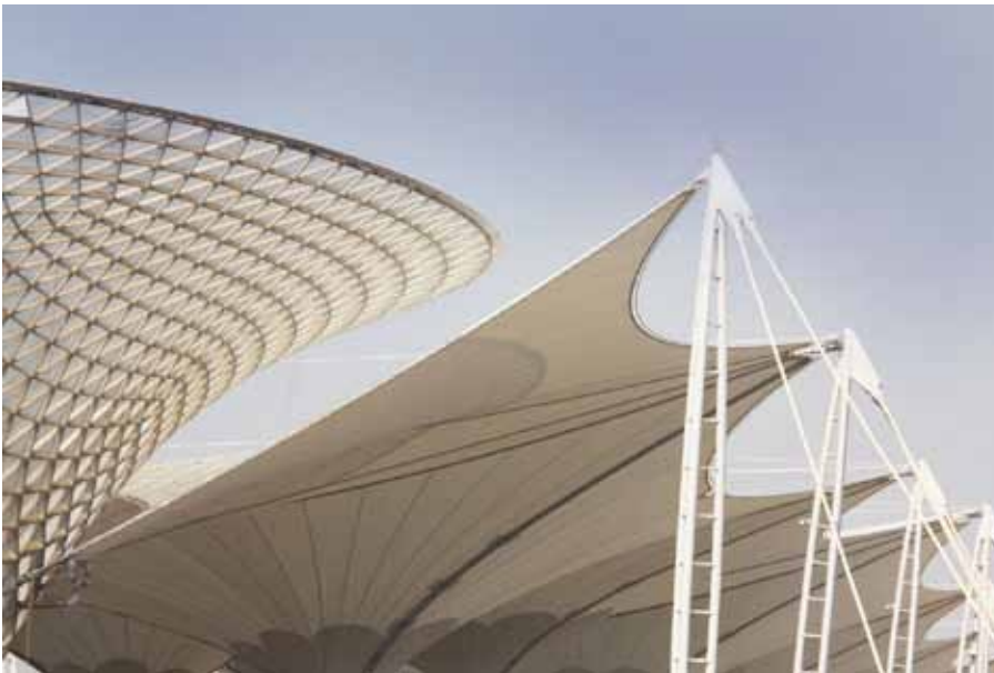
74. Struttura in tessuto e struttura in vetro
