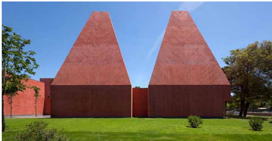
63. Vista delle coperture piramidali
