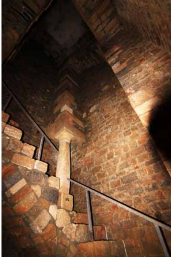
f 13 Veduta della scala della torre campanaria
