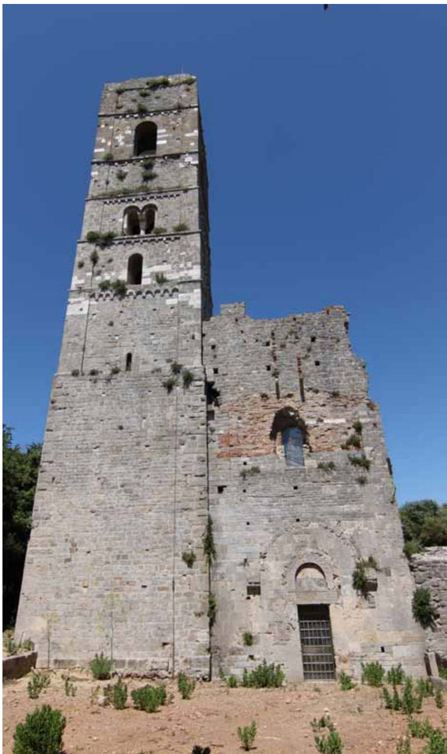
f 22 Veduta del fronte della chiesa
