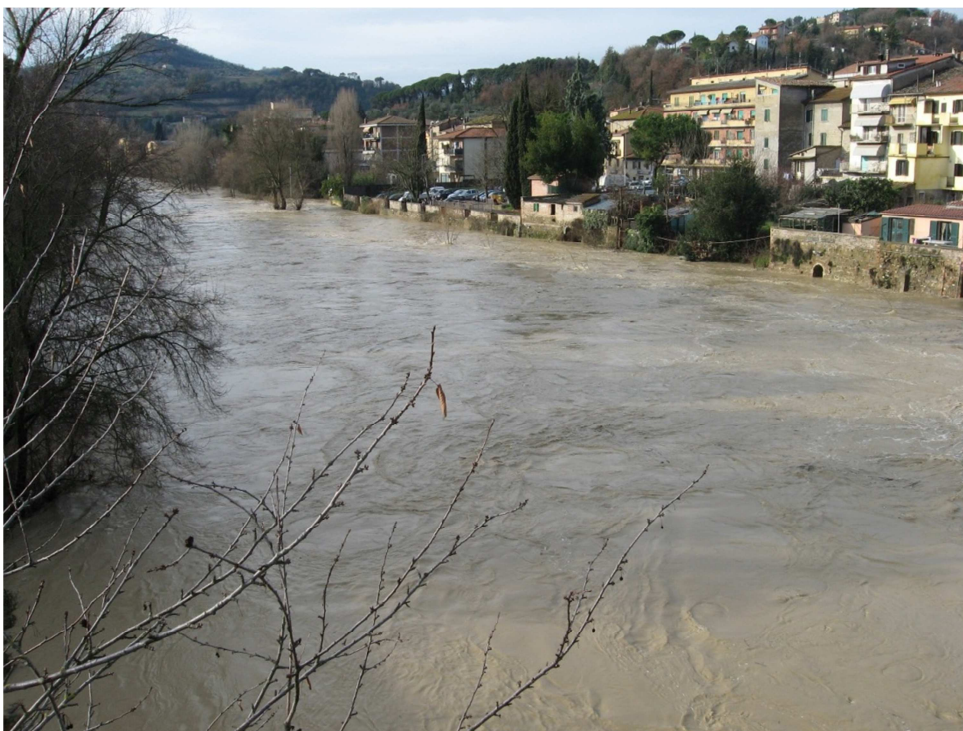
Figura 1.6 Evento di piena del gennaio 2010 alla sezione di P. Felcino del F. Tevere
