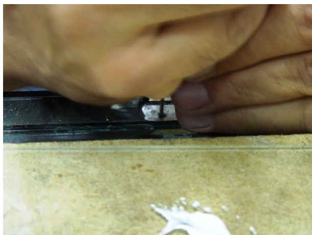
Figura 729 - Foratura della superficie metallica in corrispondenza dell'intercapedine
