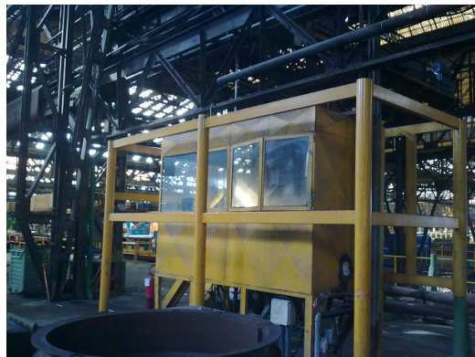
Figura 1.22: Cabina di controllo
