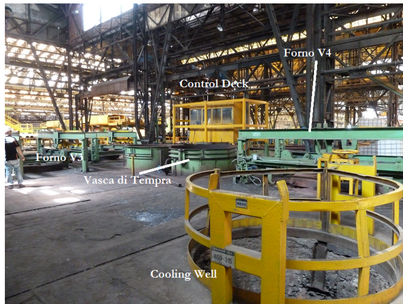
Figura 1.17: Panoramica dell'impianto di trattamento
