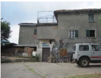
Figura 29. Prospetto est dell'edificio in disuso del vecchio ristorante "Il dosso"
