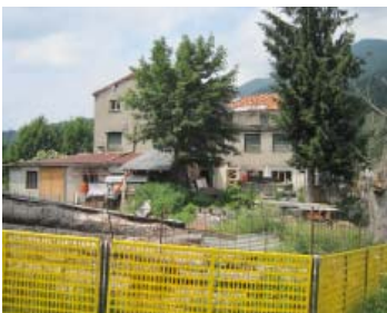
Figura 30. Prospetto sud dell'edificio in disuso del vecchio ristorante "Il dosso".
