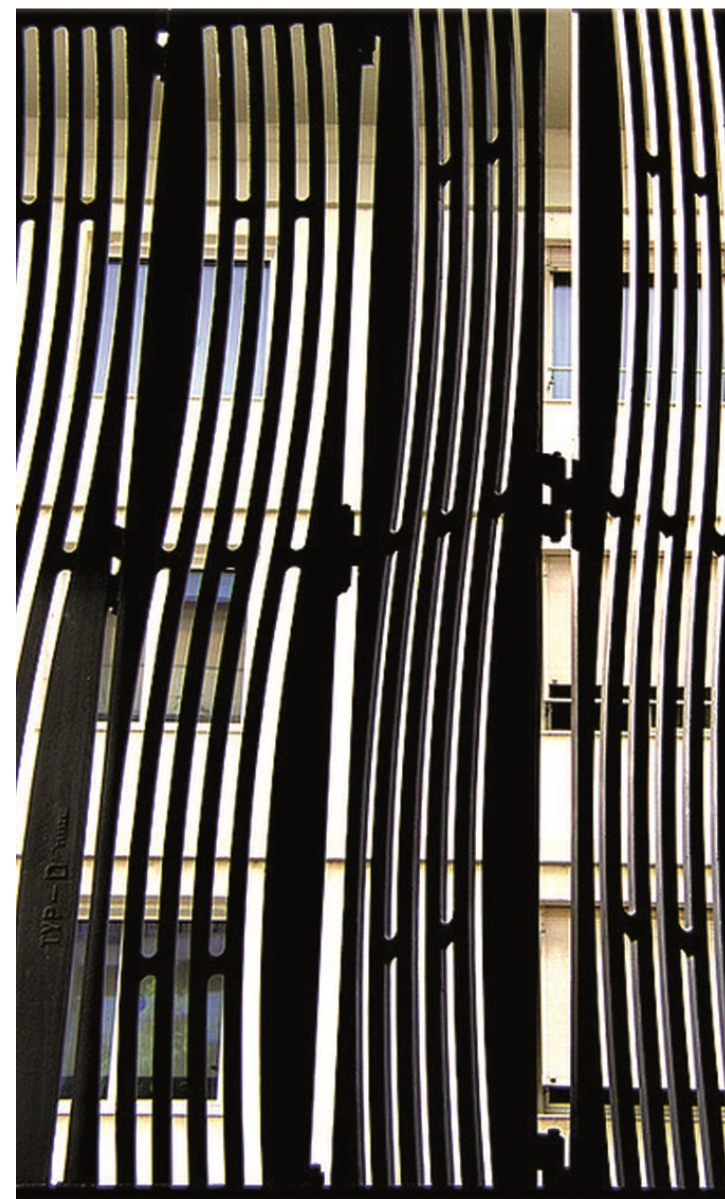
89. Schützenmattstrasse. Vista della griglia dall'interno
