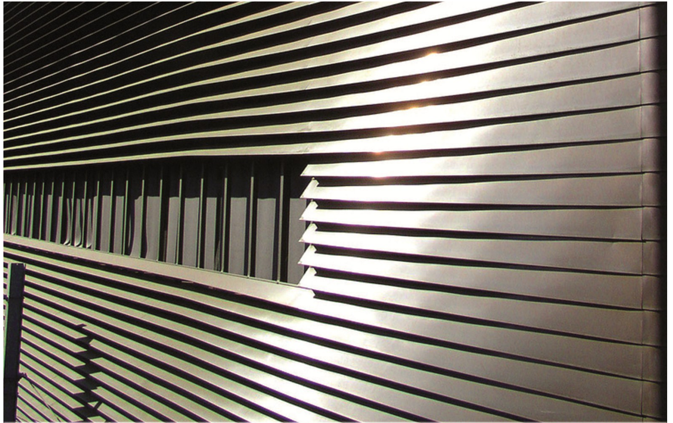
Cabina per la segnalazione ferroviaria/Basel/1998-99 Central Signal Box
