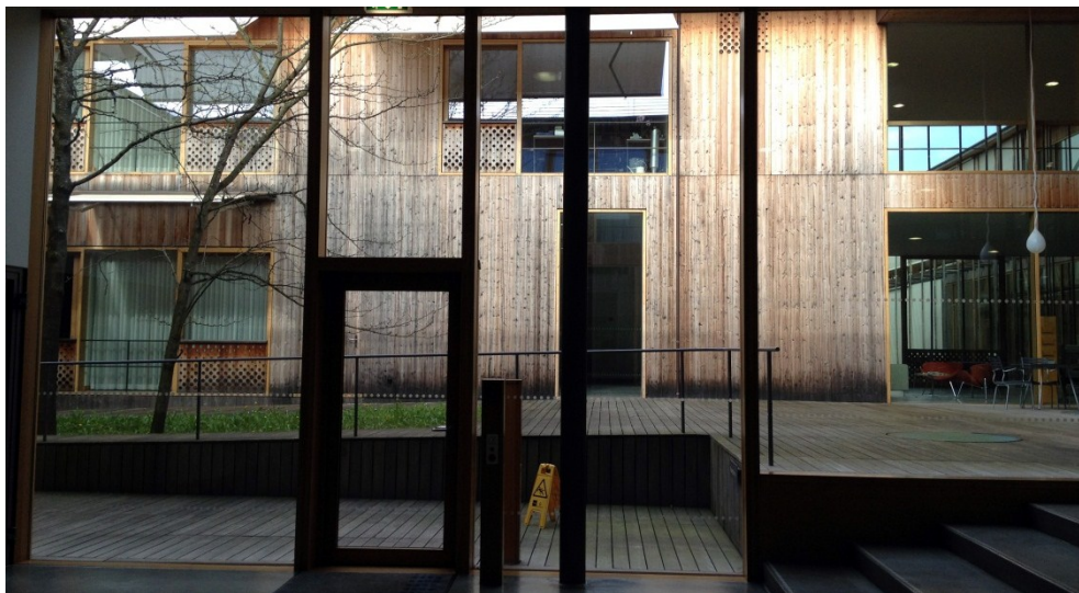
54. Rehab. Vista sul cortile interno
