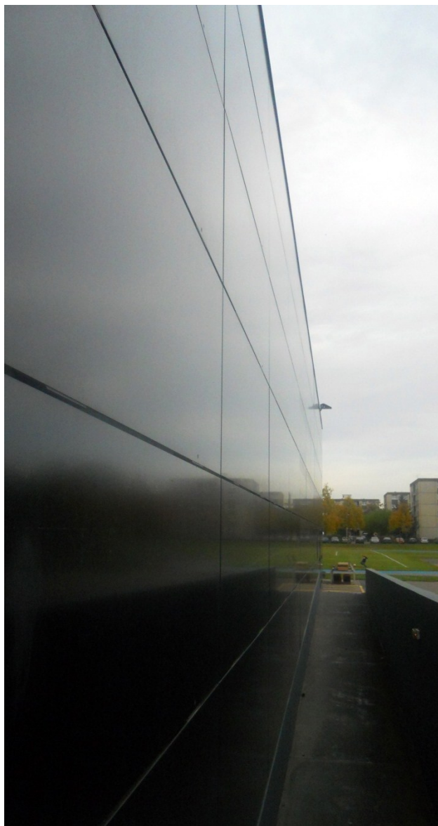
33. Rivestimento del Pfaffenholz
