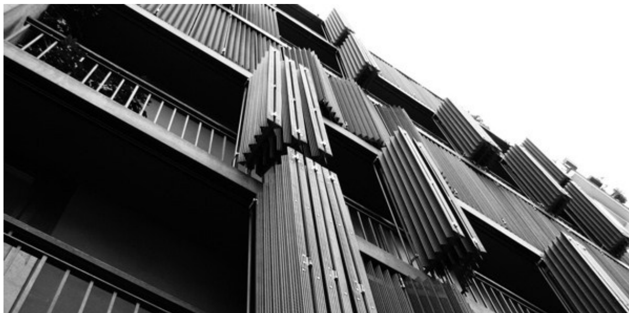
84. Appartamenti Rue de Suisse
