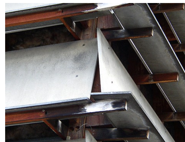
42. Dettaglio. Appoggio delle tavole sulle barre di cemento
