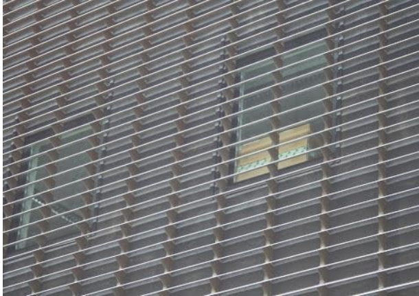
98. Cabina per la segnalazione 4 Auf Dem Wolf. Rivestimento
