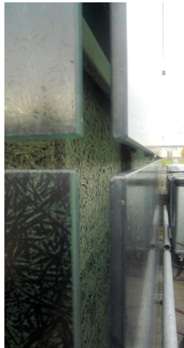
36. Dettaglio. Soluzione d'angolo priva di giunti
