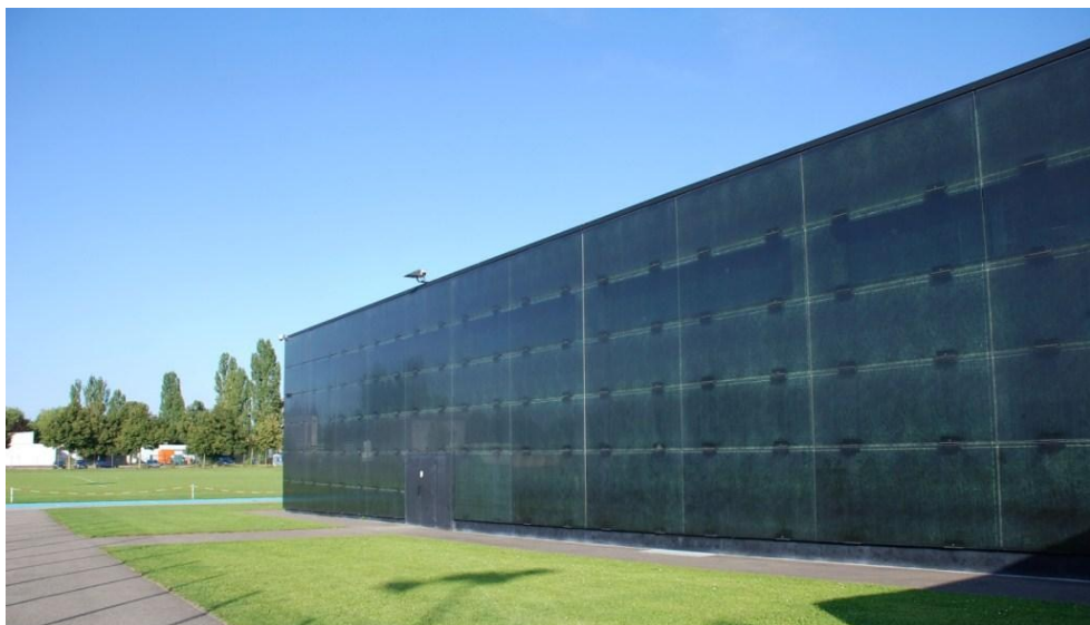
37. Esterno Pfaffenholz. L'edificio appare come un blocco monolitico
