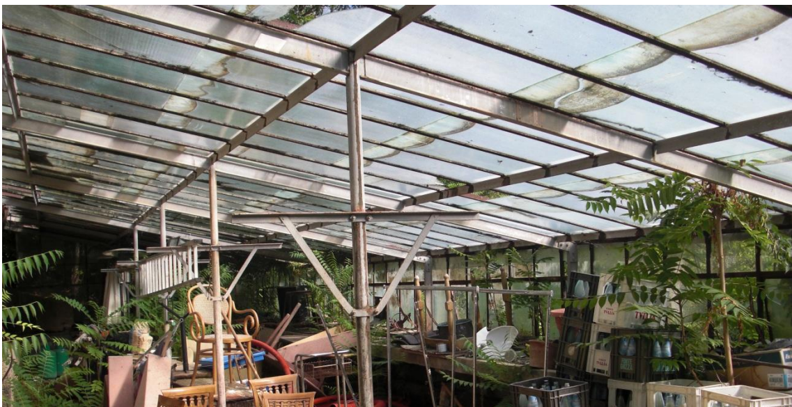
Foto 16: Chiusura orizzontale-inclinata esterna trasparente che caratterizza i locali numeri 3 e 4 della Serra
