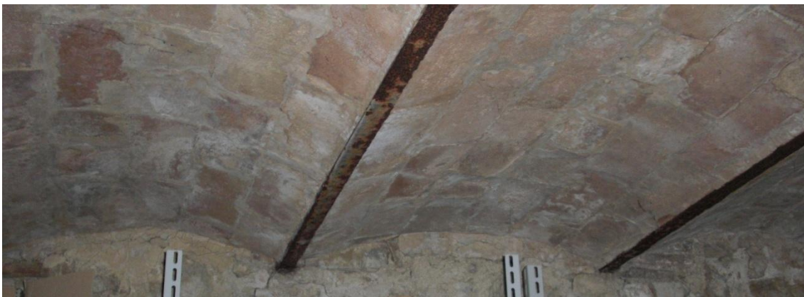
Foto 17: Chiusura orizzontale opaca esterna dei locali 1 e 2 della Serra in voltini in tavelle in laterizio con struttura in putrelle di acciaio che costituiscono l'orditura del solaio.
