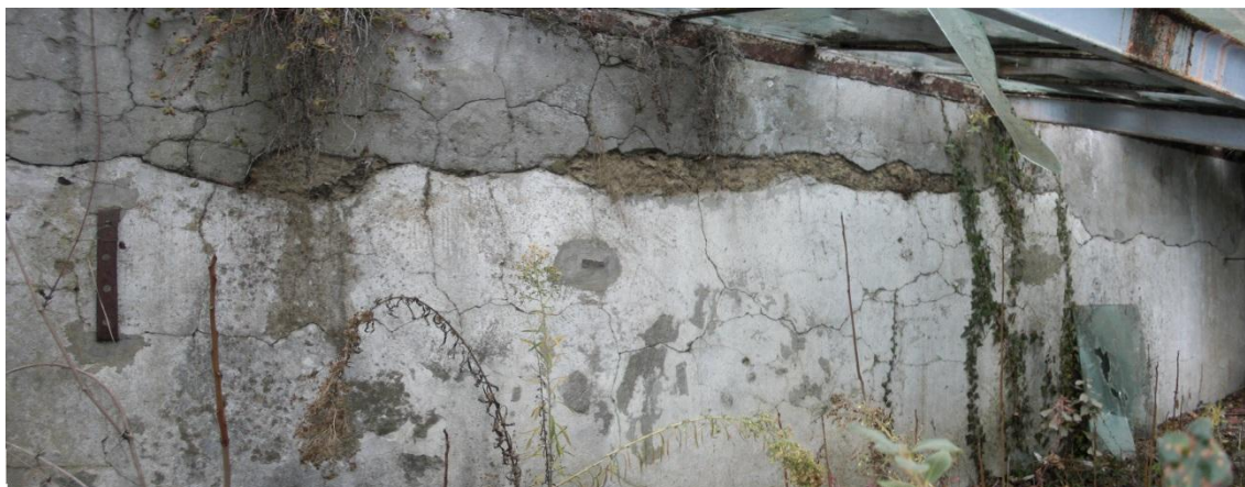
Foto 13: Dettaglio della muratura nel locale numero 4 della Serra
