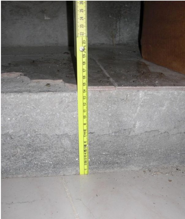
Pavimentazione dei locali numero 1 e 2 della Serra
