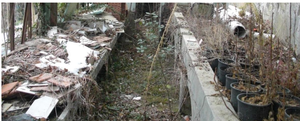
Foto 14: Pavimentazione del locale numero 4 della Serra
