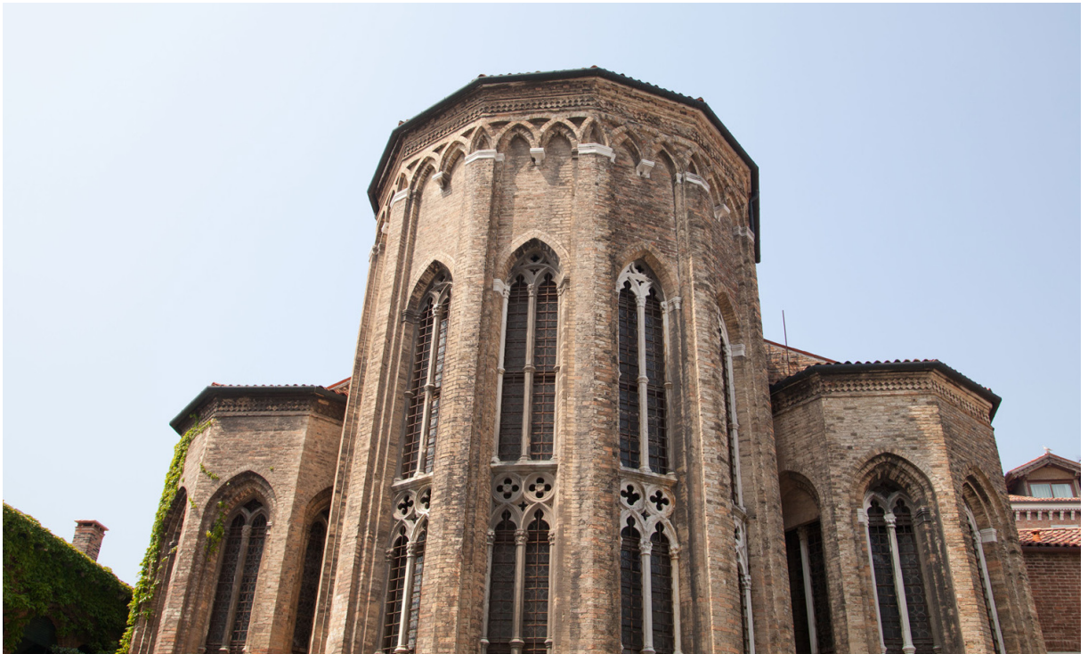
140. Ingresso chiesa di San Gregorio dal Campo dell'Abazia 141. In alto a destra: spazi annessi alla chiesa, su Campo dell'Abazia 142 In basso a destra: particolare retro chiesa di San Gregorio
