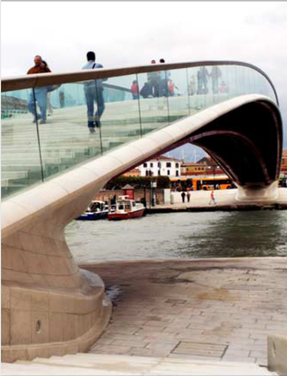
13. Ponte della Costituzione , Calatrava, Venezia, 2010
