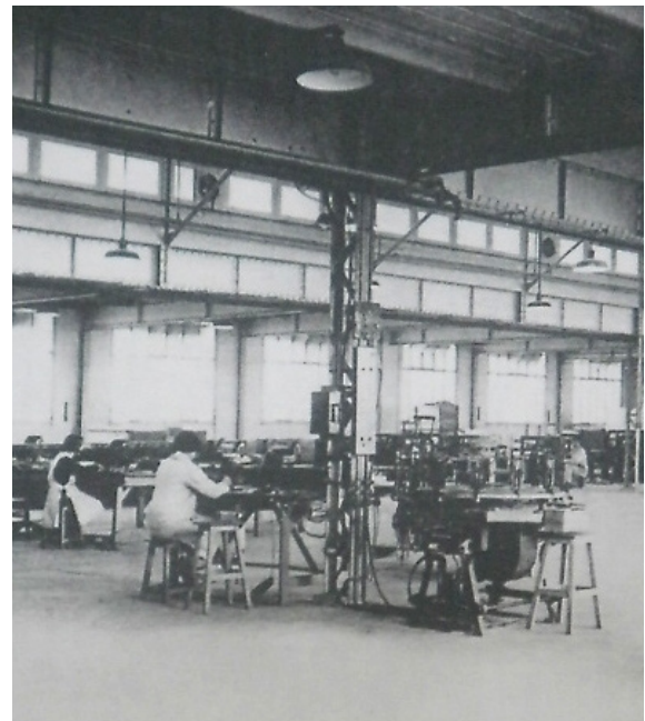
80. Fabbrica tessile in un capannone industriale, Parigi, 1940
