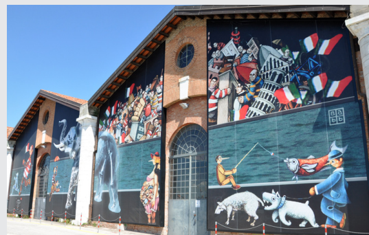
23. Esterno capannoni spazio Thetis
