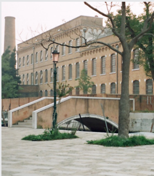
117-118. Ingresso esterno e interno aule Ex-Cotonificio
