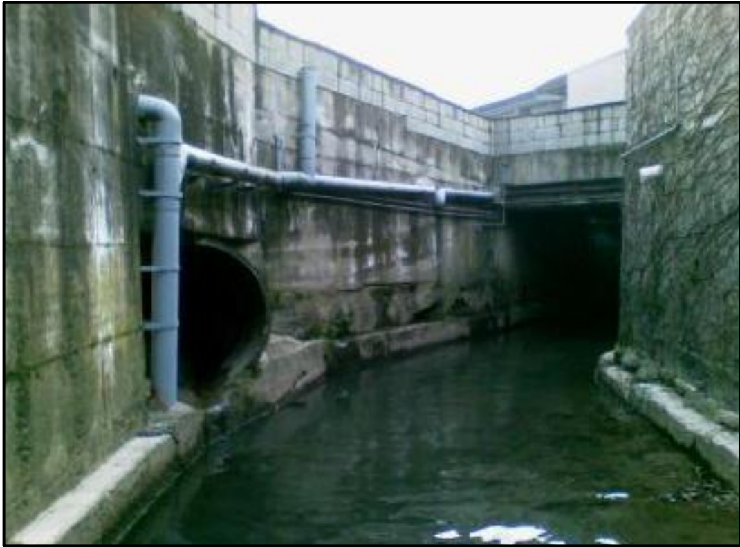
Figura 3 Vista di valle della tombinatura nel comune di Renate
