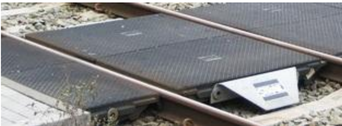
Figura 98: posizionamento piastre STRAIL
