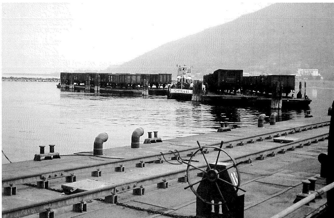
Figura 73: carri su pontoni in arrivo allo scalo di Paratico
