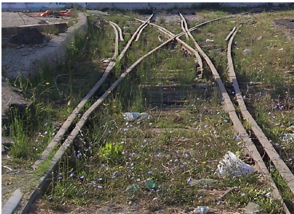
Figura 77: deviatoio triplo in disuso
