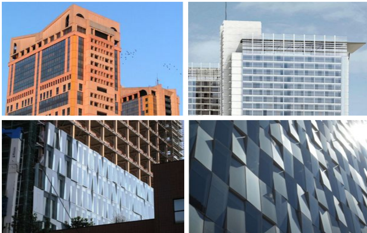
Immagine 4.2 – Centro Direzionale Garibaldi
