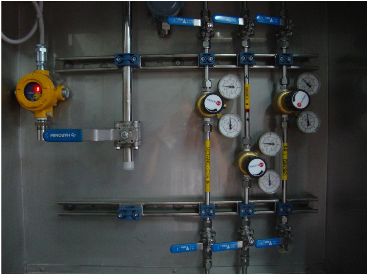
Figura 3.9 Linea del gas naturale
