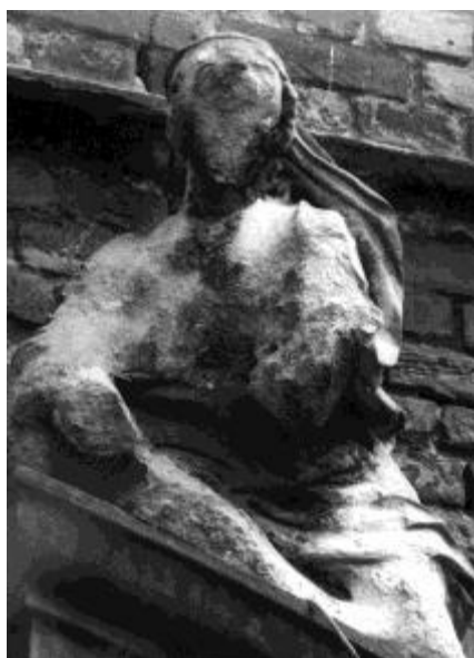
Figura 1.2: Effetto delle piogge acide sui monumenti
