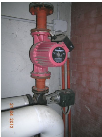
Figura 3.33 Circolatore tradizionale esistente e circolatore elettronico ad alto rendimento
