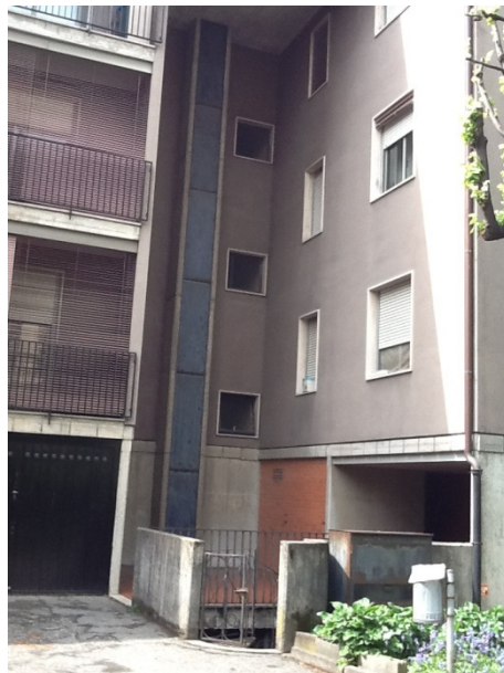
Figura 1.6 Ingresso al locale tecnico interrato per mezzo di una scala a chiocciola, posizionato sul fronte ovest
