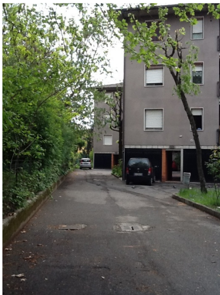
Figura 1.3 Percorso carrabile di accesso alle rimesse sul fronte ovest del complesso residenziale
