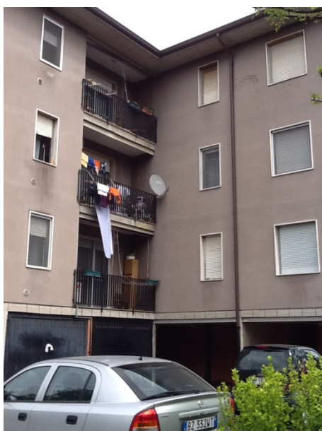
Figura 1.2 Zoom della facciata dove si mostrano le autorimesse al piano terra e i successivi tre piani ad uso residenziale
