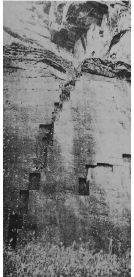
lavorazione sulla Roccia di età romana. Campodolcino.
