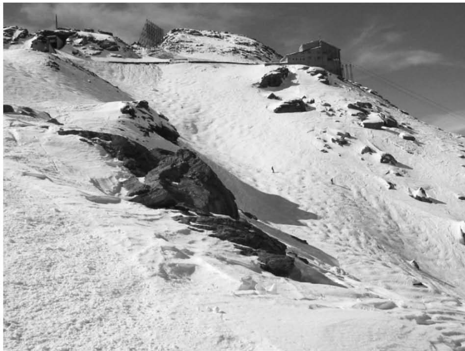
La parete di partenza del Canalone. A monte, sulla destra, la stazione della funivia. Al centro, il tunnel pedonale coperto e il trasmettitore di Radio24CH. A sinistra, il vecchio impianto skilift da anni sostituito dalla seggiovia scoperta a due posti. Sullo sfondo, la cima del Pizzo Groppera [2948 m s.l.m.].
