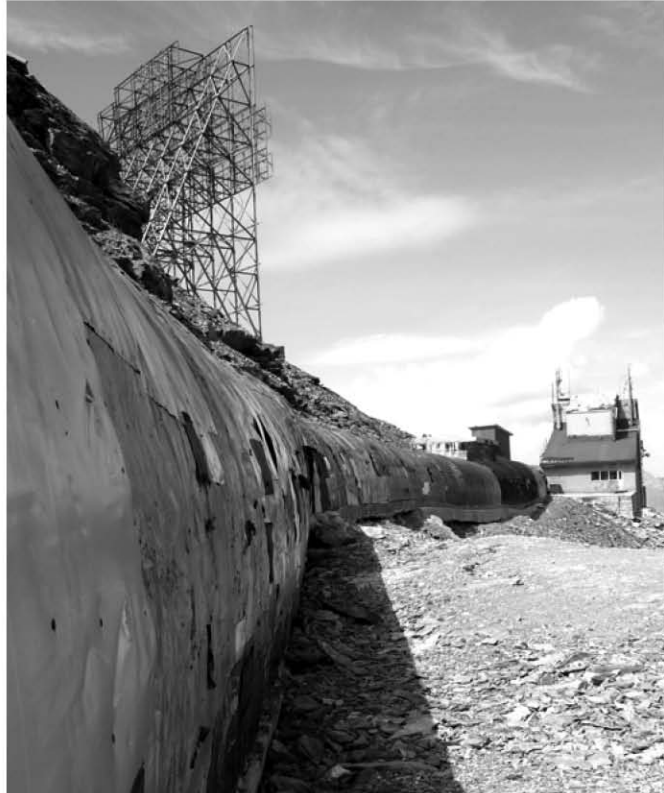
La stazione e il tunnel come si presentano oggi.
