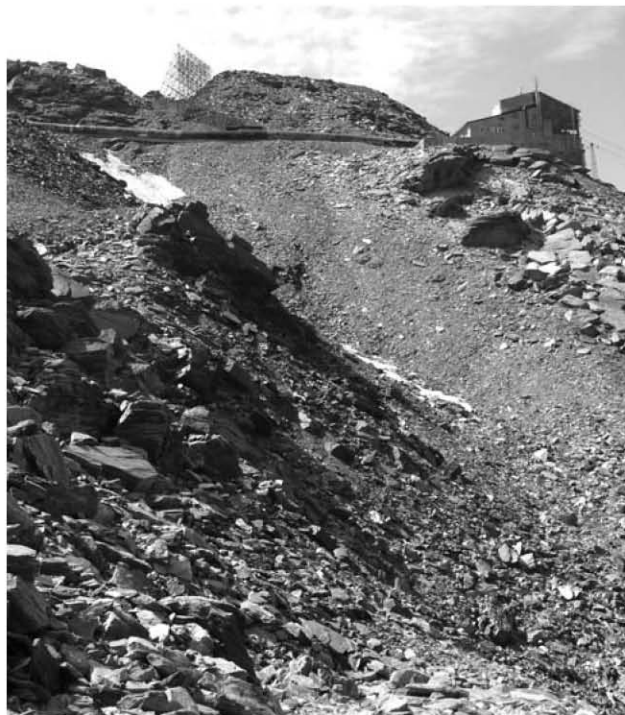
La parete di partenza del Canalone. A monte, sulla destra, la stazione della funivia. Al centro, il tunnel pedonale coperto e il trasmettitore di Radio24CH. A sinistra, il vecchio impianto skilift da anni sostituito dalla seggiovia scoperta a due posti. Sullo sfondo, la cima del Pizzo Groppera [2948 m s.l.m.].
