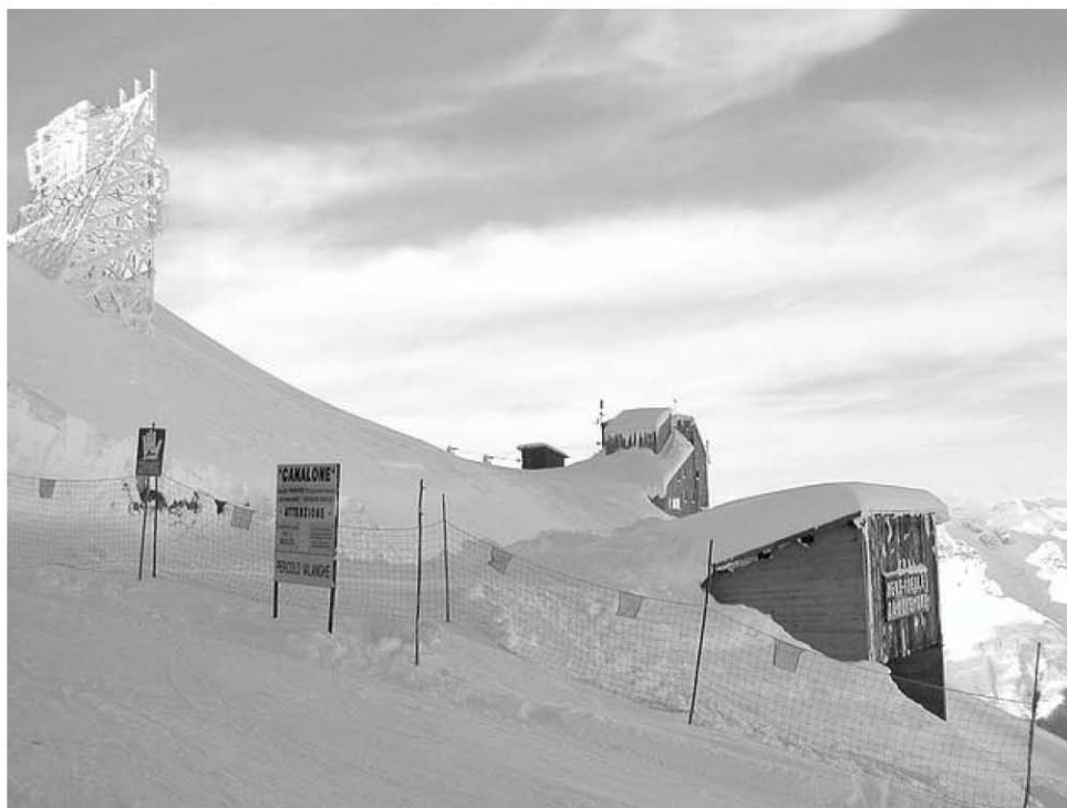
Sulla sinistra, l'antenna radio. Al centro, la stazione della funivia che collega Cima Sole. Coperto dalla neve, il tunnel che porta agli impianti di Val di Lei. Recintata, la partenza del Canalone.
