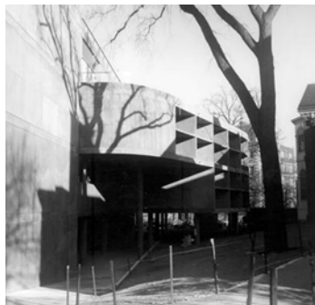
Carpenter Art Center a Cambridge Massachusetts, Stati Uniti, 1954 configurazione del brise-soleil a seconda dell'orientamento - fotografia di archivio
