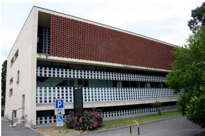
I. Gardella Dispensario Antitubercolare di Alessan- dria, 1933-38 Vista della facciata Sud - fotografia dell'autrice
