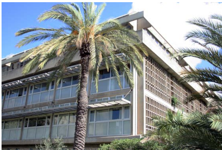
Università di Tel Aviv, Israele Edifici del Campus schermature variabili in base all'orientamento (Nord e Ovest) - fotografie dell'autrice
