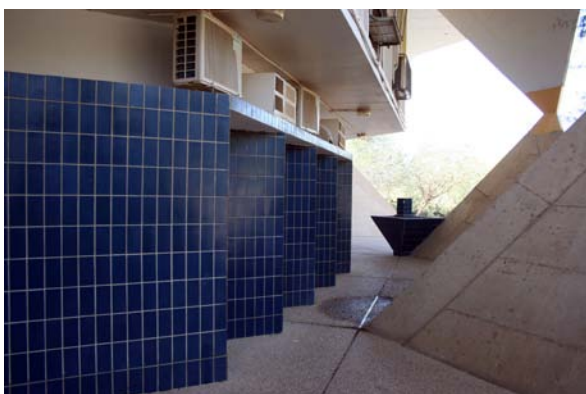
Vista del camminamento esterno: parete rivestuta in ceramica tra i pilastri piramidali in cemento grezzo - fotografia attuale
