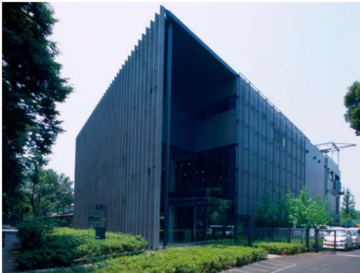
Schermature fisse lame verticali in pietra di Shirakawa Facoltà di Agraria di Tokyo, Giappone, 2000 - Arch. K. Kuma
