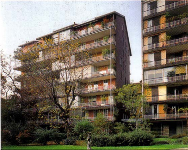
I. Gardella Casa in Via Marchiondi, Milano (1951- 1953) Vista del fronte Sud - fotografia attuale
