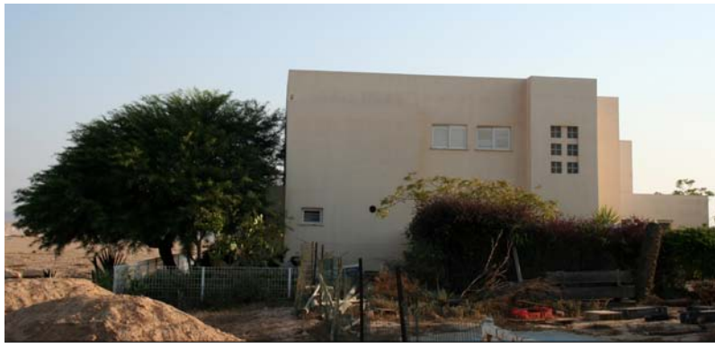
Vista del fronte nord - fotografia dell'autrice
