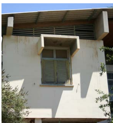
Vespaio di ventilazione della co- pertura A SINISTRA pannello areante A DESTRA sostituzione errata con pannello pieno - fotografia dell'autrice
