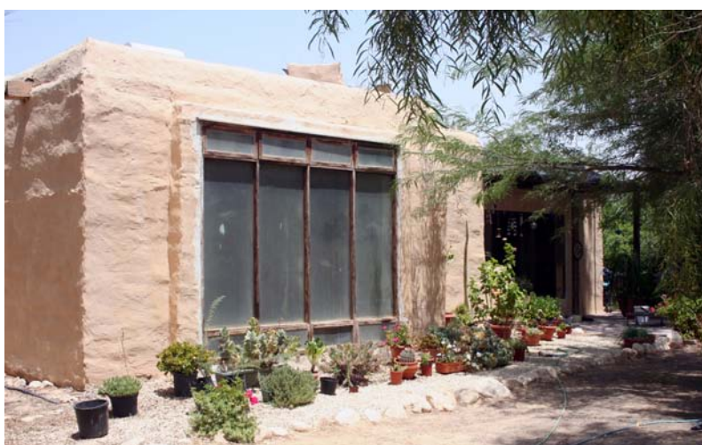
La grande apertura con la scher- matura a prismi rotanti, fronte sud. - fotografia dell'autrice
