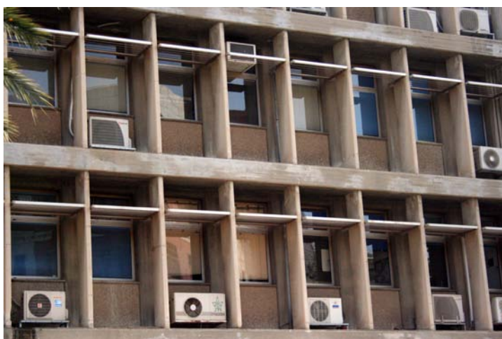
Università di Tel Aviv, Israele Edifici del Campus La forma non è la risposta integrazione di impianti di condizionamento per risolvere il problema del surriscaldamento degli edifici - fotografie dell'autrice
