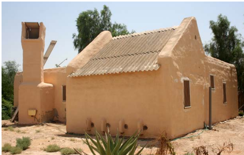
Vista nord-ovest della casa con la torre del vento rivolta verso i venti dominati (nord-ovest) - fotografia dell'autrice
