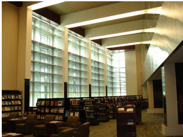
Lightshelves effetto all'interno dell'ambiente Biblioteca del Century College di White Bear Lake, Minnesota - fonte: doralco.com
