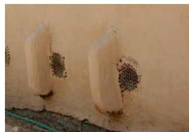
Comportamento termico dell'edificio, ventilazione naturale del pavimento e particolare delle bocchette di ventilazione a pavimento - fotografia del disegno originale, CDAUP
