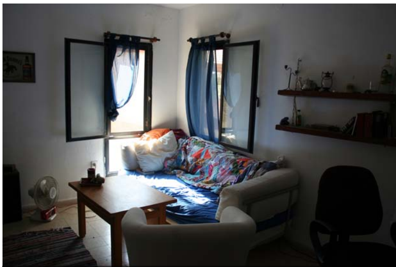
Vista interna del soggiorno: le finestre d'angolo sono troppo ravvicinate per favorire la ventilazione incrociata. - fotografia dell'autrice
