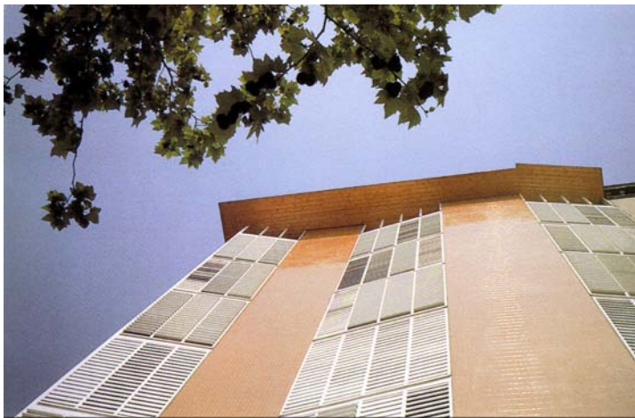
J. A. Coderch Casa a la Barceloneta, 1952-55 Vista della copertura - fotografia attuale
