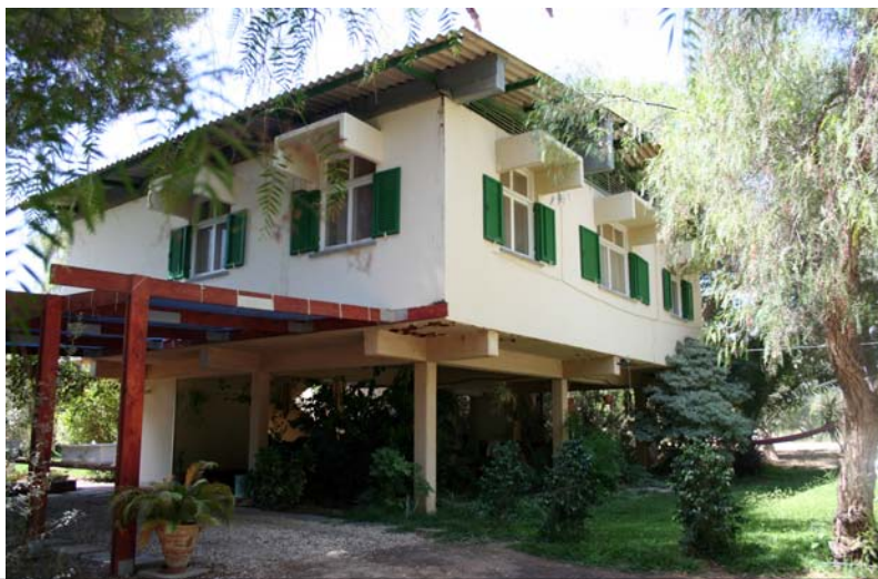
Vista di un alloggio uso della vegetazione nello spazio tra i pilotis. - fotografia dell'autrice
