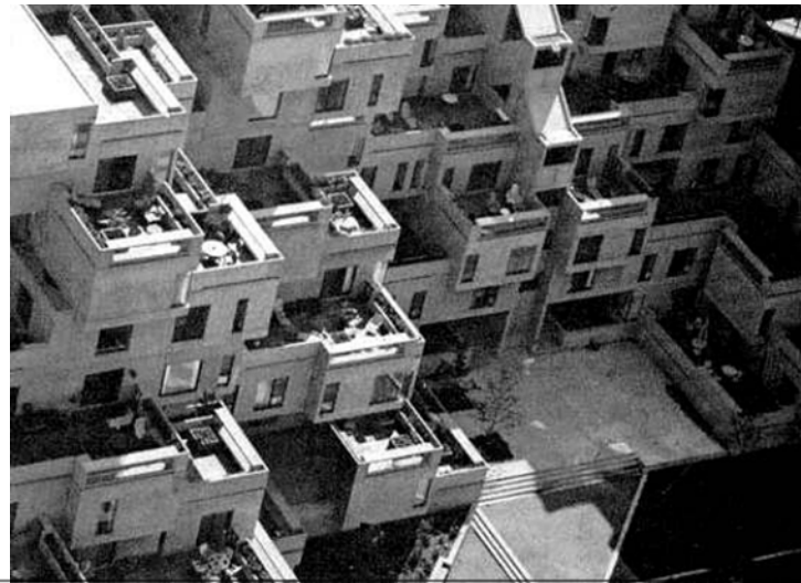
Habitat '67 Complesso residenziale realizzato in occasione dell'Esposizione Universale di Montreal nel 1967 - Arch. Moshe Safdie
