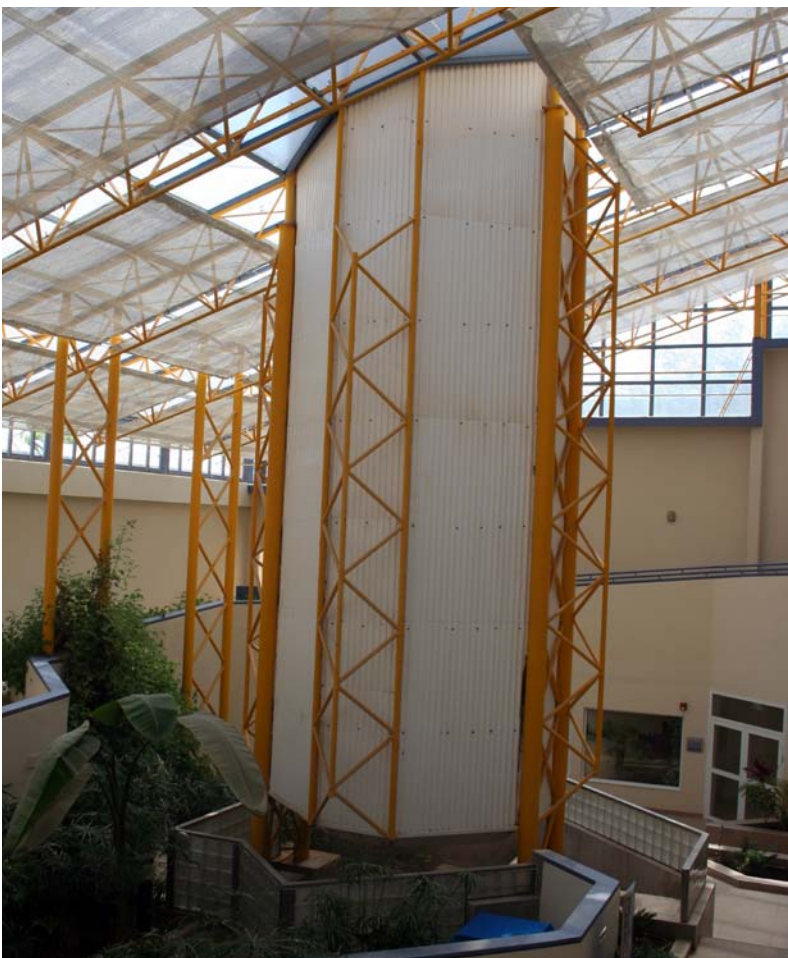
La torre di raffrescamento per evaporazione rivolta verso i venti dominanti (N-O) - fotografie dell'autrice
