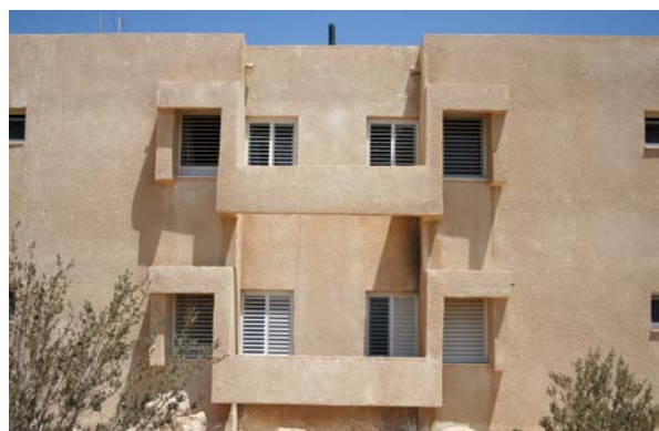
Vista del fronte sud: particolare dell'elemento di schermatura della facciata - fotografia attuale
