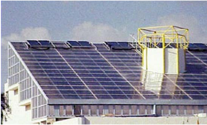
La copertura "selettiva" e la torre di raffrescamento passivo - fotografia per gentile concessione dell'Arch. Dadid Pearlmutter, CDAUP
