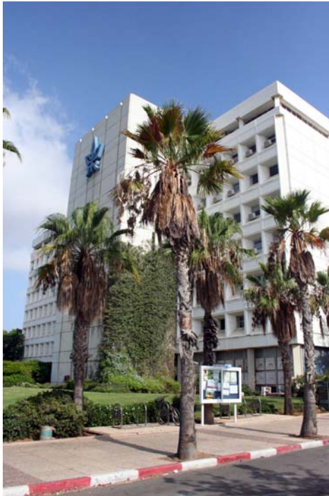
Università di Tel Aviv, Israele Edifici del campus universitario - fonte: tau.ac.il
