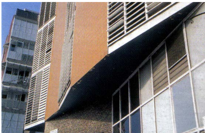
J. A. Coderch Casa a la Barceloneta, 1952-55 Particolare dell'attacco del basamento con il volume degli alloggi. - fotografia attuale
