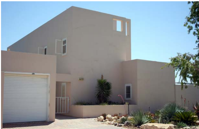
Vista del fronte ovest lato d'ingresso all'edificio. - fotografia dell'autrice
