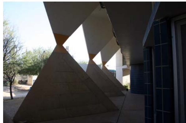
Vista del camminamento esterno: gioco volumetrico dei pilastri piramidali in cemento grezzo - fotografia attuale
