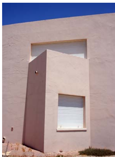
Particolare delle finestre A SINISTRA lato nord, piccole aperture in altezza per captare le brezze notturne. A DESTRA lato sud, grandi aperture e finestra strambata per captare l'orientamento est verso la valle di Zin - fotografie dell'autrice
