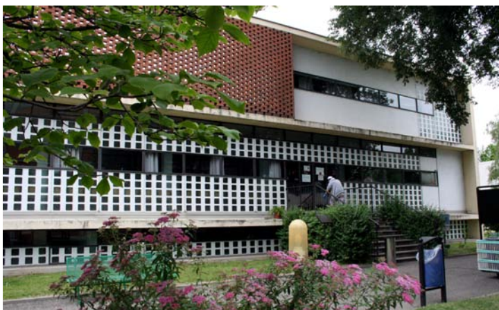
I. Gardella Dispensario Antitubercolare di Alessan- dria, 1933-38 Vista della facciata Sud - fotografia dell'autrice
