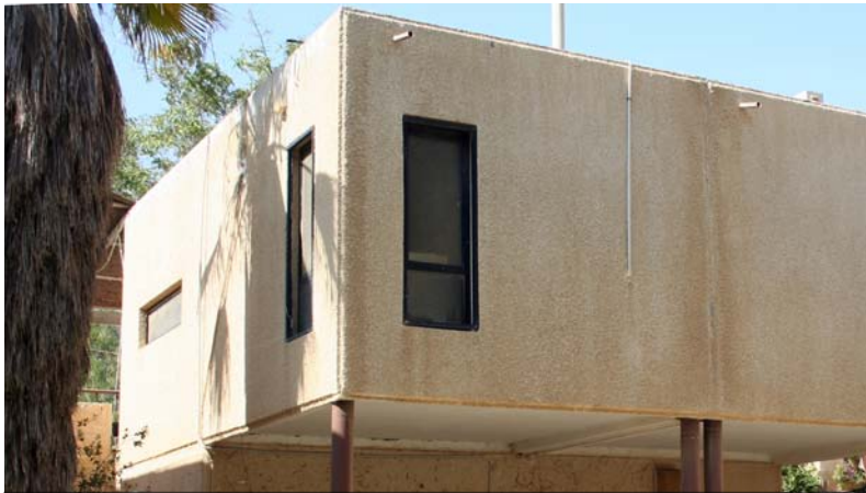
Vista prospettica delle finestre d'angolo del soggiorno, troppo ravvicinate per favorire la ventilazione incrociata. - fotografia dell'autrice
