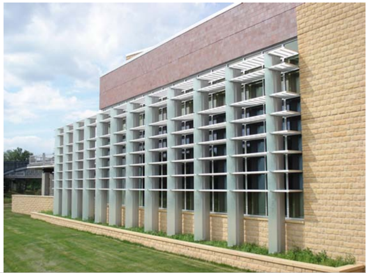
Lightshelves effetto in facciata Biblioteca del Century College di White Bear Lake, Minnesota - fonte: doralco.com
