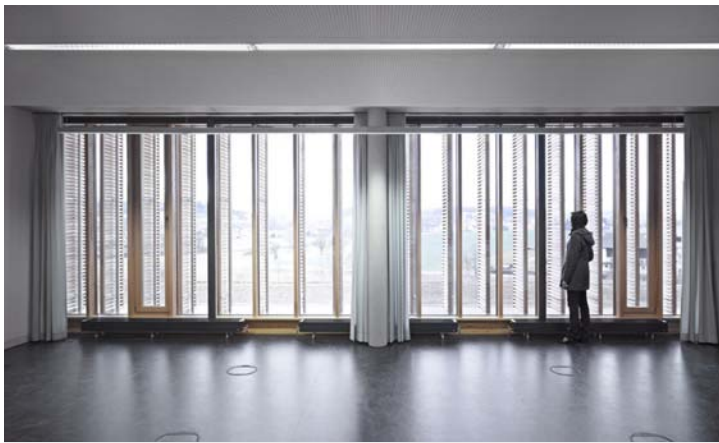
Schermature mobili Imposte girevoli in legno di larice Università di Scienze applicate di Aalen Germania 2006 - MGF Architekten
