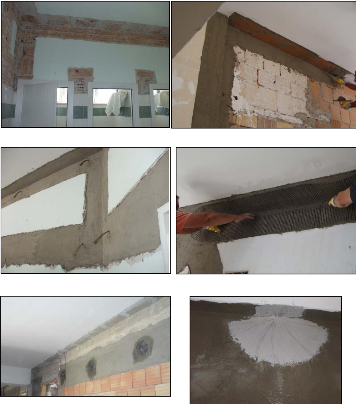
Figure da 1.15 a 1.20 – Fasi esecutive del collegamento di pannelli murari alla struttura portante
