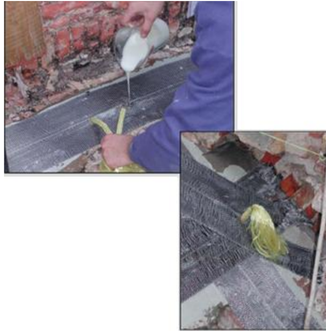
Figura 1.8 – Fasi esecutive di messa in opera del connettore con fiocco
