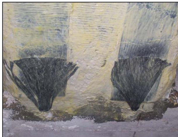
Figure 1.10, 1.11, 1.12 – Fasi esecutive di rinforzo a flessione di travi in c.a. con fiocco edile
