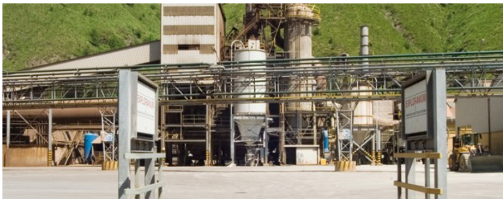
Figura 2.5 - Vista dell'impianto Waelz di Ponte Nossa (BG)
