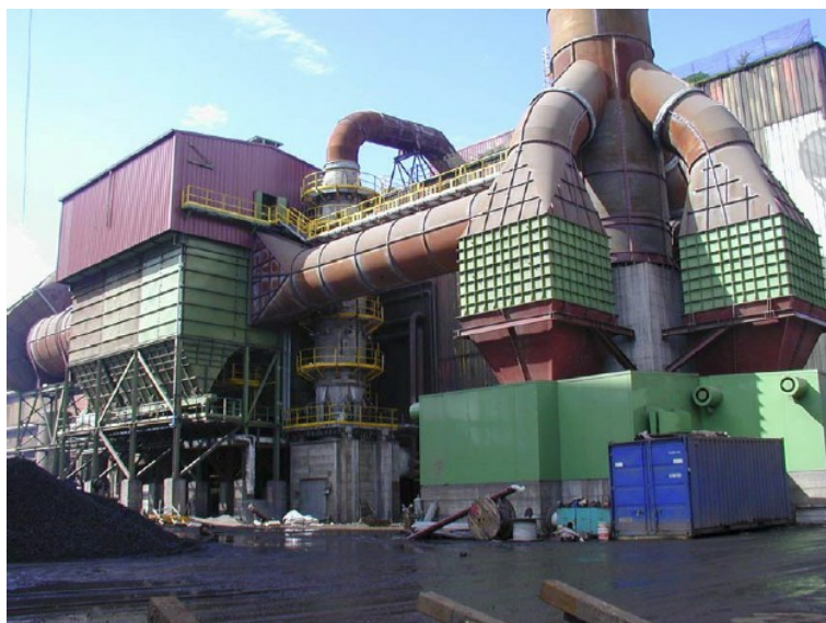
Figura 1.7 - Esterno di un'acciaieria elettrica: notare le dimensioni dell'impianto di abbattimento fumi
