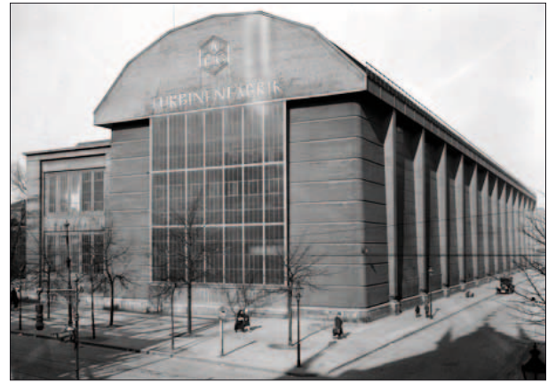
Fig. 04: Peter Behrens, centrale elettrica A.E.G. "Turbinenfabrik" di Berlino, 1927.
