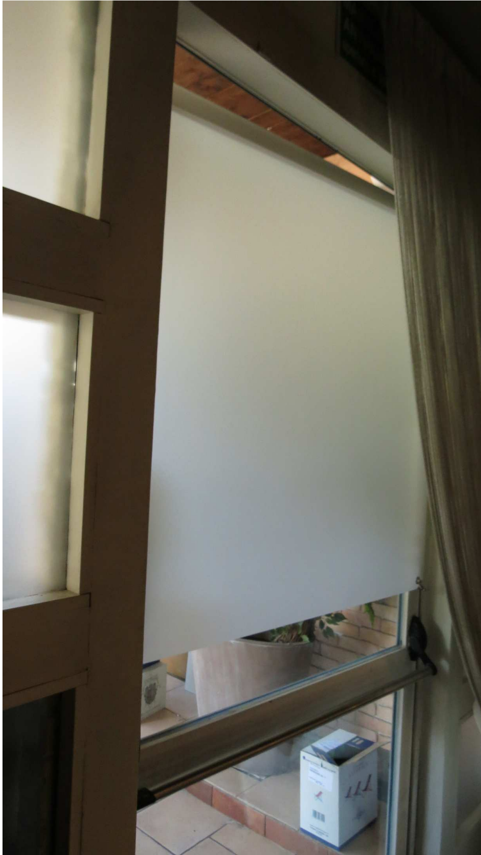
Figura 7.89. Installazione della pellicola translucida di Microsorber® all'uscita di sicurezza
