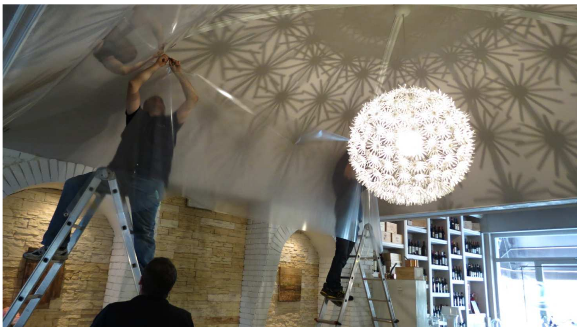
Figura 7.84. Installazione della pellicola di Microsorber nella cupola
