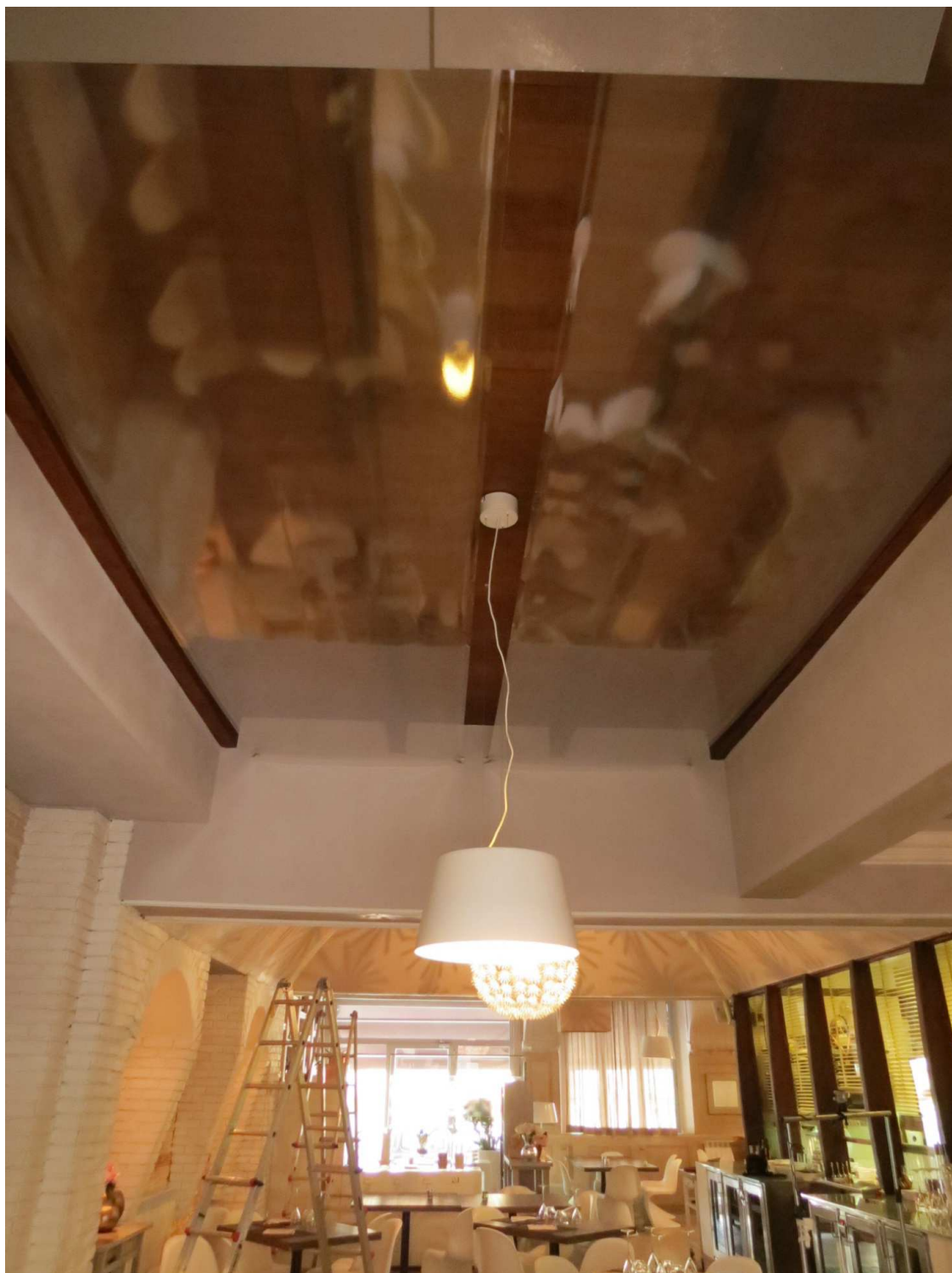
Figura 7.90. Zona bar; sul soffitto è stata installata la pellicola di Microsorber® in doppio strato
