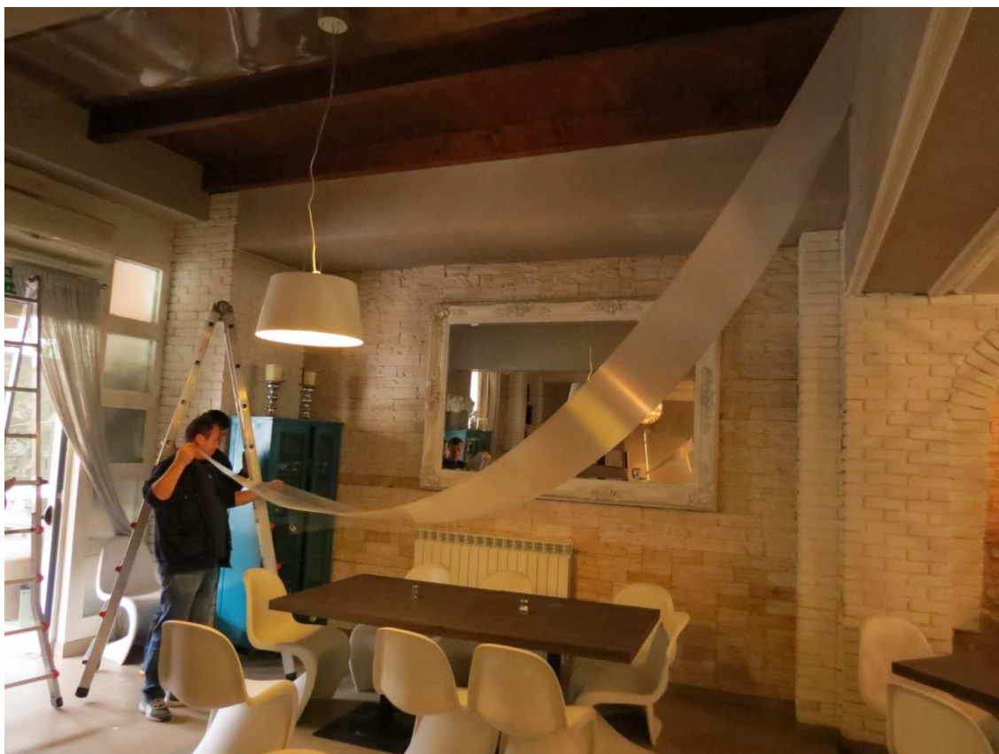
Figura 7.83. Installazione della pellicola di Microsorber® nella sala bar
