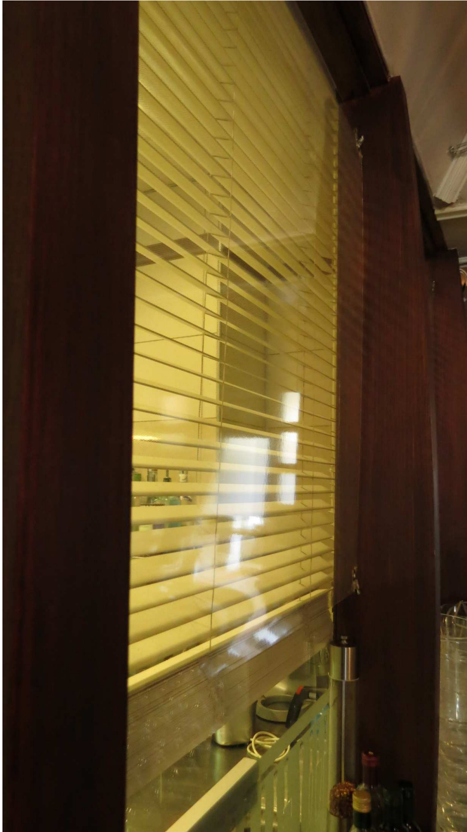
Figura 7.87. Pellicola applicata ad una delle vetrature della cucina; il foglio, affinché il materiale funzioni, deve trovarsi almeno a 3cm dalla superficie trattata
