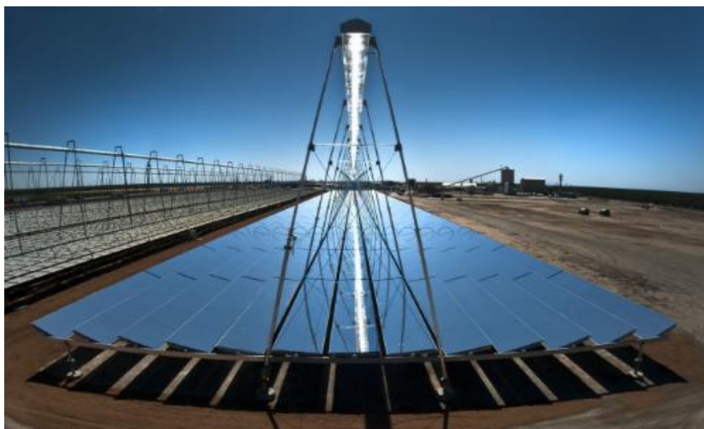
Figura 8: Impianto energetico che utilizza la tecnologia a collettori di Fresnel (CLFR)
