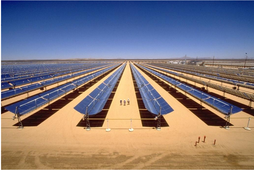
Figura 7: Campo solare di un impianto a parabole lineari
