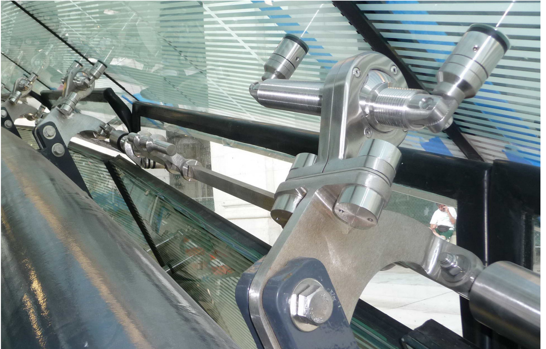
particolare del sistema costruttivo modulare - Washington Bike Station
