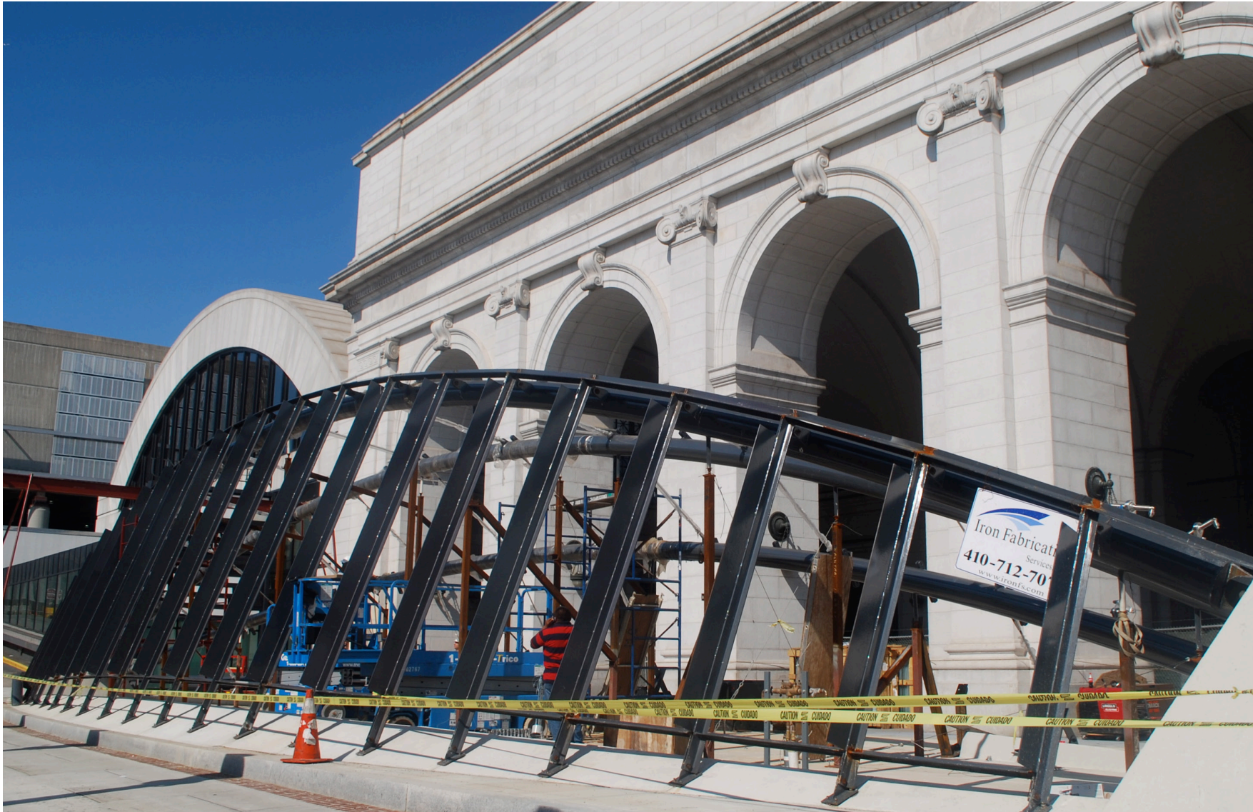
scheletro in acciaio posato sul massetto in cemento - Washington bike Station
