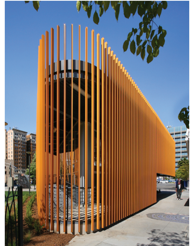
integrazione architettonica, Long Beach bike station
