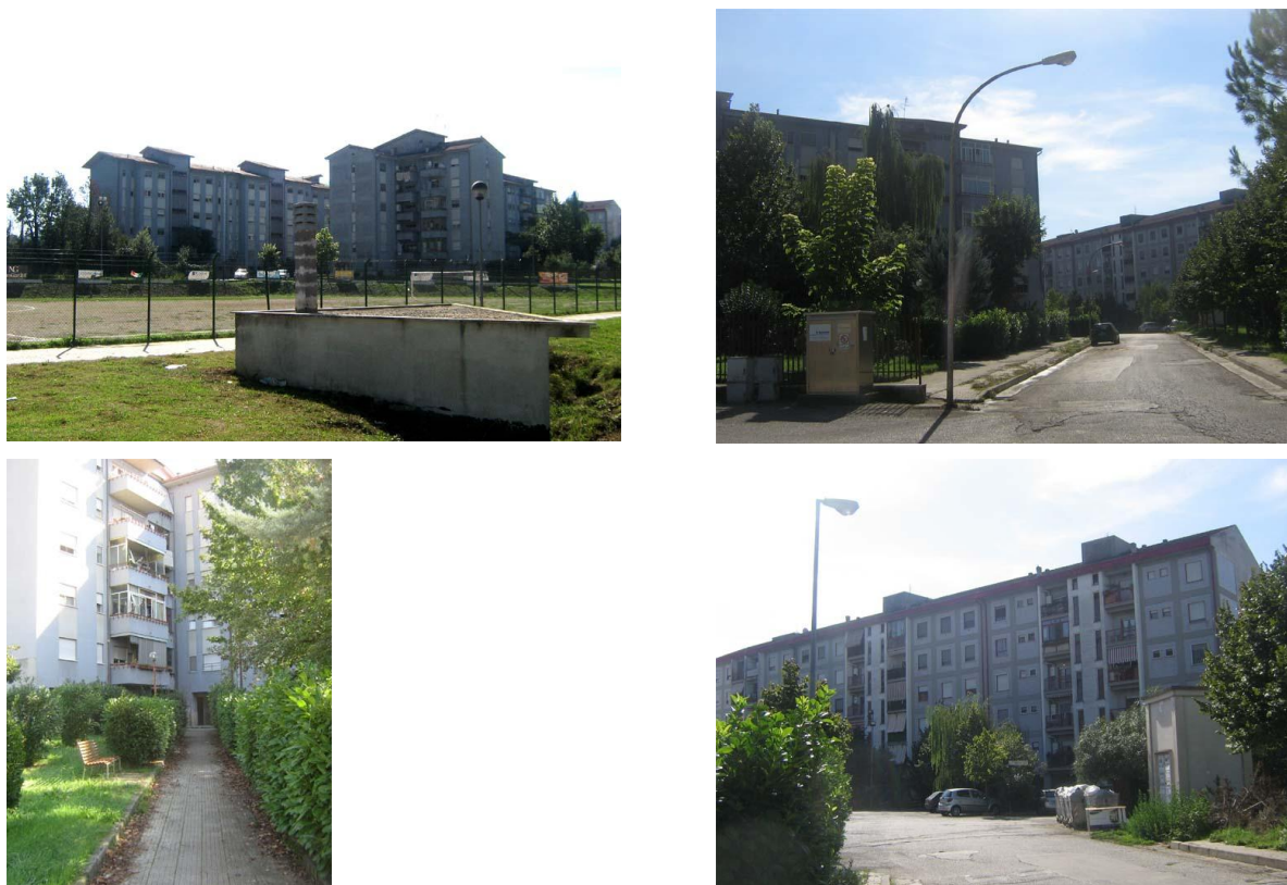
Fig. 37 - Foto relative agli edifici di edilizia residenziale pubblica degli anni Ottanta nel quartiere San Bartolomeo del Comune di Cassino e al contesto circostante. Fonte: sopralluogo del 05/10/2012
