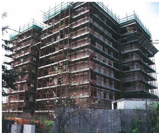
Fig. 54 - Edificio in costruzione nel Comune di Ceprano Fonte: periodico dell'ATER Luglio-Agosto 2012
