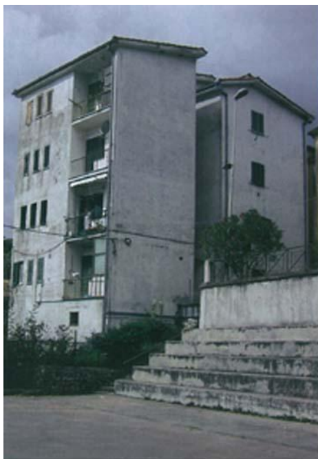
Fig. 55 – Edificio sottoposto a un intervento di recupero nel Comune di Torrice Fonte: periodico dell'ATER Luglio-Agosto 2012
