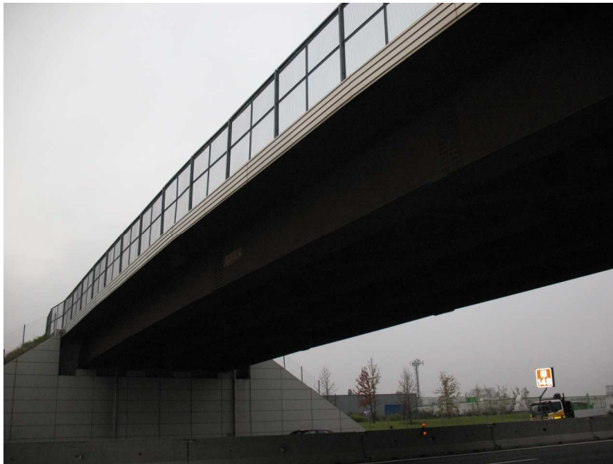
Figura 3.8 - Esempio di cavalcavia su autostrada A4 (impalcato a 4 travi), vista frontale, travi in acciaio corten con veletta in acciaio inox
