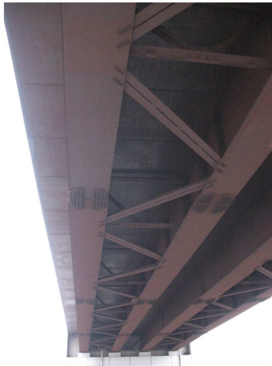
Figura 3.9 - Esempio di cavalcavia su autostrada A4 (impalcato a 4 travi), vista intradosso, travi in acciaio corten con coppelle metalliche
