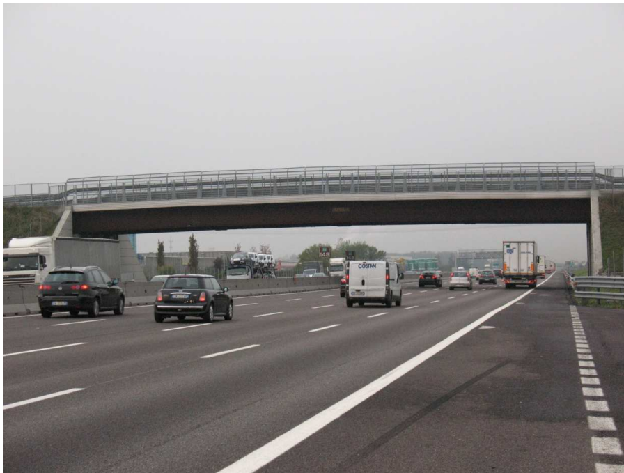
Figura 3.7 - Esempio di cavalcavia su autostrada A4 (impalcato a 4 travi), vista frontale, travi in acciaio corten con veletta in acciaio inox
