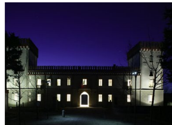
1.2.2.C. Facciata del Castello
