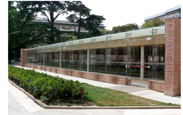
2.6.1.F. Vetrata dell'edificio
