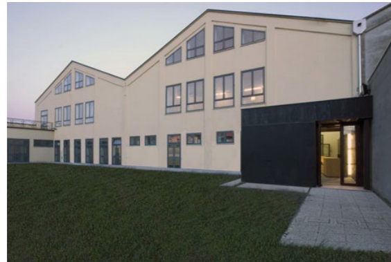
2.2.1.A. Veduta esterna dell'ex capanificio
