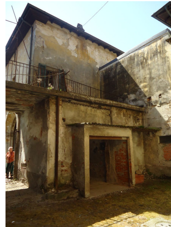
3.2.2.L. Vista 5 - interno della corte - garage
