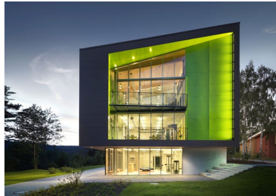
2.2.2.I. Vista esterna della struttura
