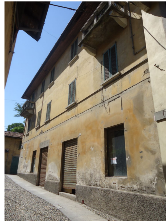
3.2.2.C. Vista 1 - prospetto nord-est su via Cavour
