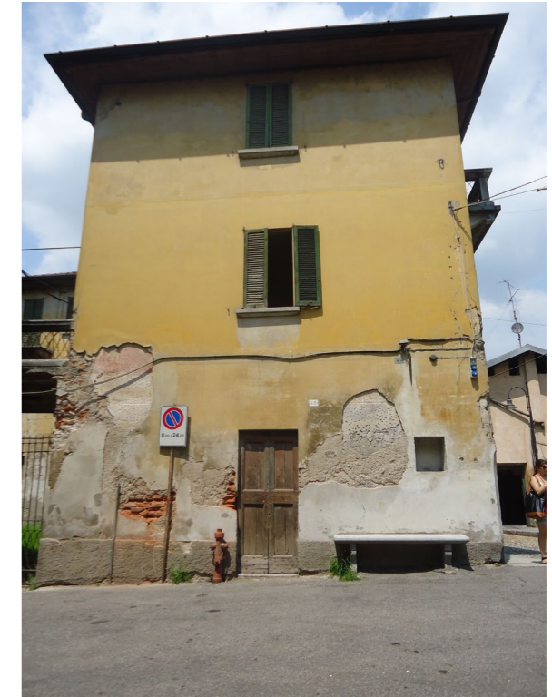
3.2.2.D. Vista 2 - prospetto sud-est su via Roma
