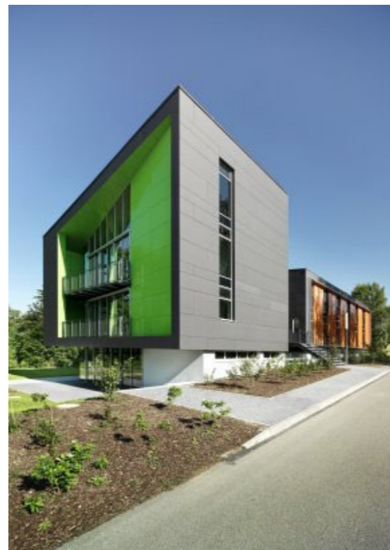
2.2.2.O. Vista esterna del complesso
