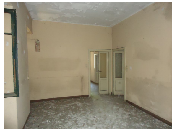
3.2.2.P. Vista 8 - interni secondo piano
