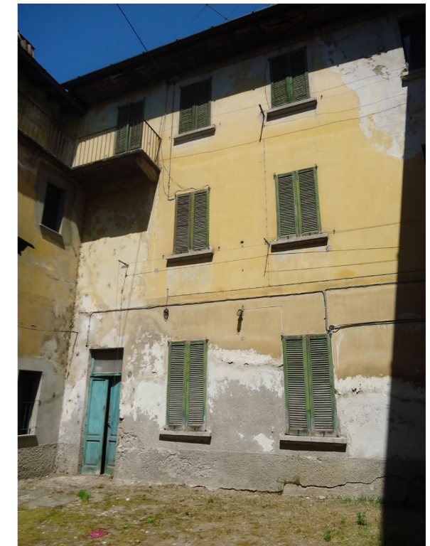
3.2.2.M. Vista 6 - interno della corte - Prospetto sub est sulla corte
