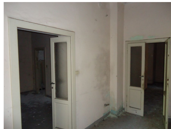
3.2.2.O. Vista 7 - interni secondo piano
