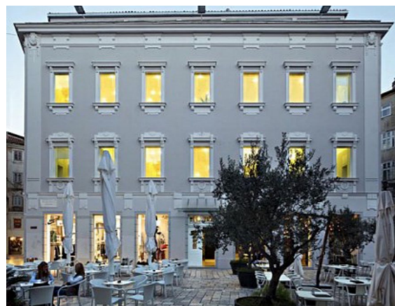
3.3.3.F. Vista esterna dell'ostello
