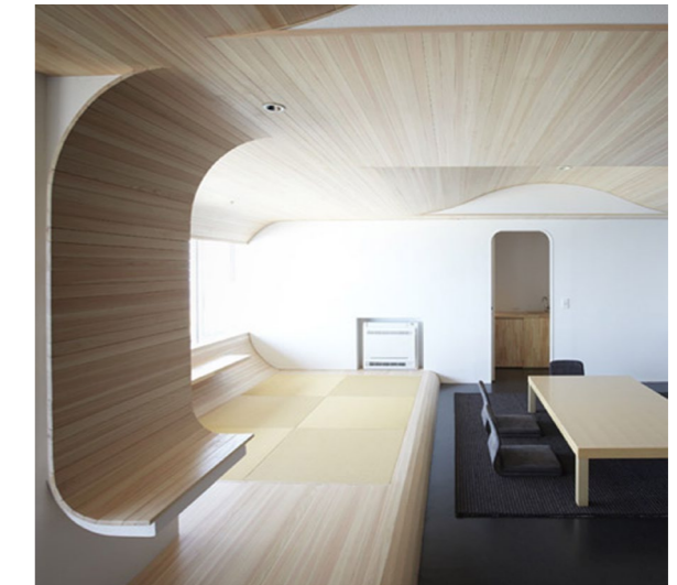
3.3.5.C Zona living - elemento ligneo che fa da soffitto panca e parete con ripiani
