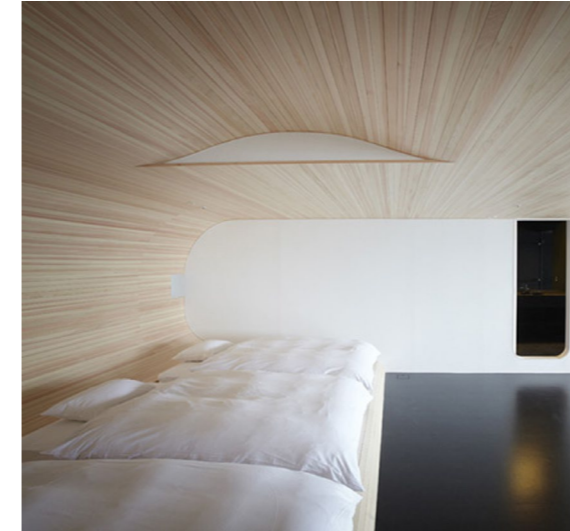
3.3.5.B. Elemento ligneo che corre dal soffitto alla parete per definire il piano letto
