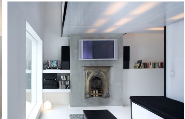
3.3.3.D. Soggiorno - soffitto il policarbonato
