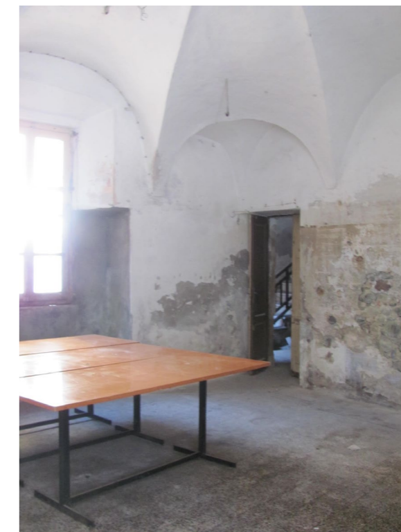
3.2.2.H. Vista 4 - interno della sala voltata al piano terra
