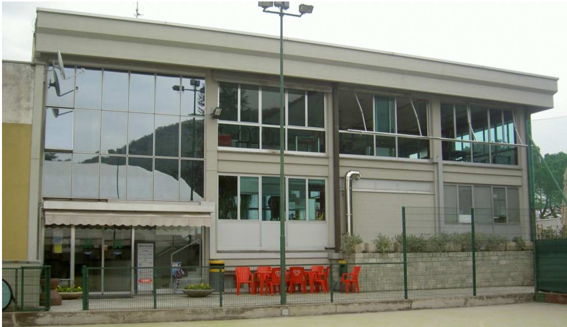
Fig. 3.3 – Prospetto sud-ovest (cono n.1) che cattura il fronte ingresso dell'edificio.
