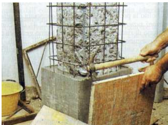
Figg. 6.71, 6.72 – Esempi di incamiciatura pilastro in c.a. e consolidamento trave in c.a. tramite applicazione di strisce di CFRP.
