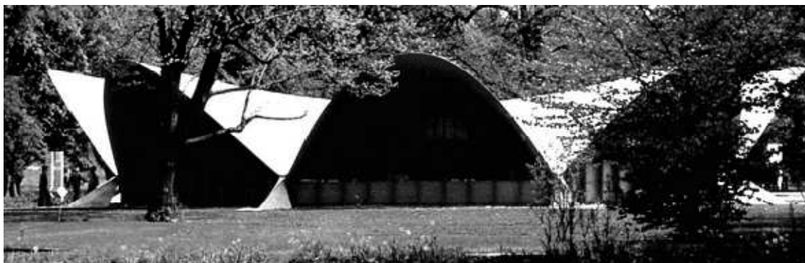
Fig. 4.4 – Riferimento progettuale: esempio di copertura curvilinea realizzata in Textile Reinforced Concrete (TRC). Si noti l'esiguo spessore della sezione.
