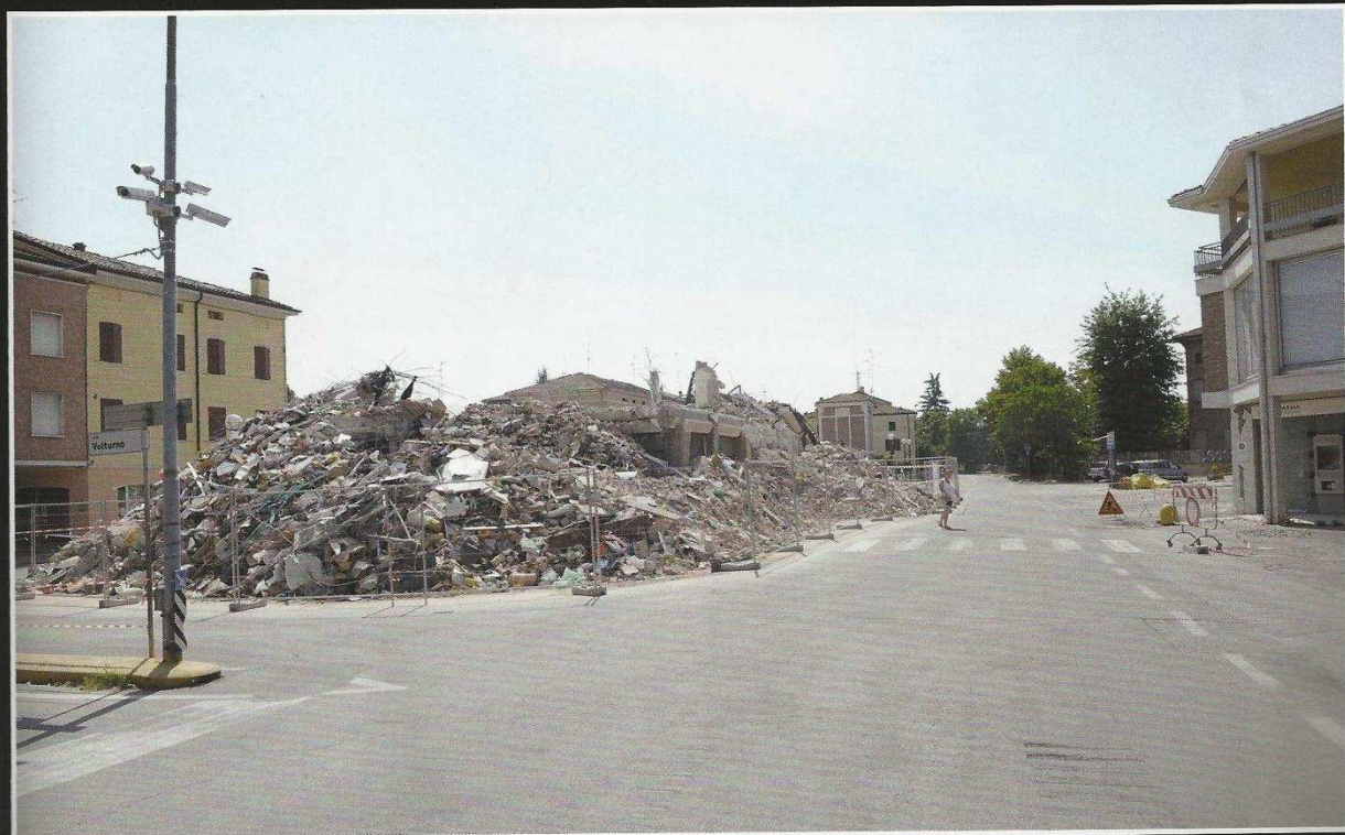
Cavezzo, la stessa strada del centro dopo il terremoto
