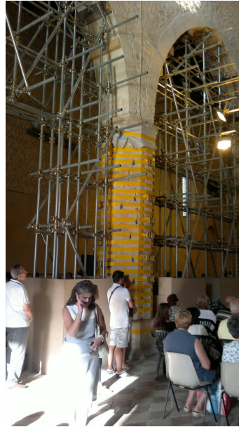
Figura 8.4: Intervento di confinamento su un pilastro della Basilica dell'Aquila
