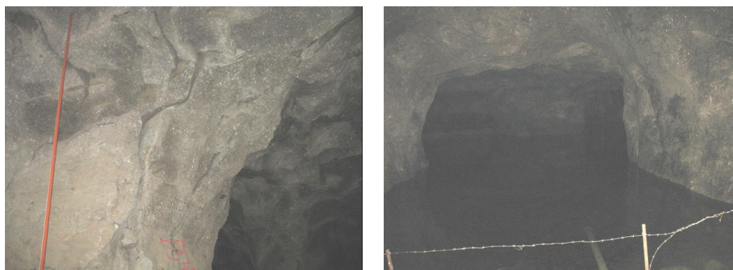
(a) Frattura in un pilastro
