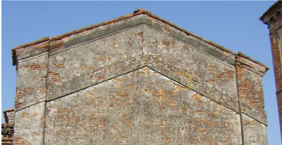
Figura 2-7 Prospetto est della chiesa, particolare della cornice in mattoni.
