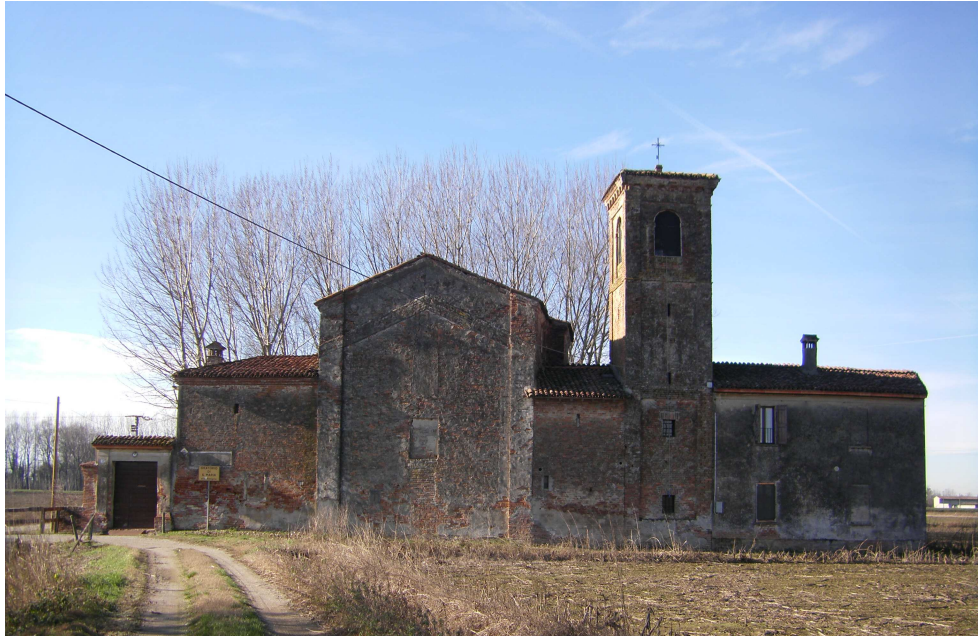
Figura 3-4 Veduta del prospetto est del complesso.
