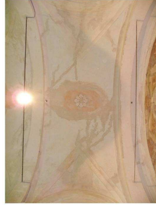
Intradosso della volta O15, elemento interagente: Facciata V7 [14-05-2012]
