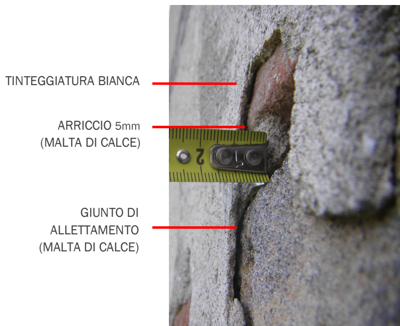
Figura 3-11 Particolare della superficie intonacata della facciata sud della chiesa.
