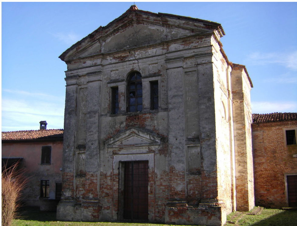
Figura 3-2 Veduta del prospetto ovest della chiesa.
