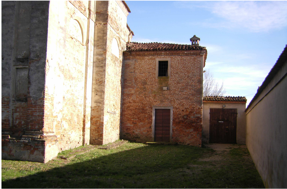
Figura 3-6 Veduta del prospetto ovest della sagrestia.
