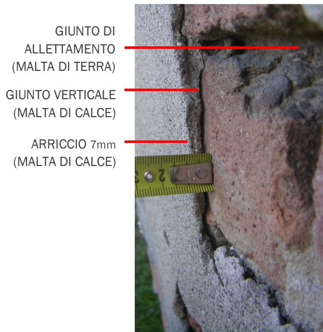
Figura 3-10 Particolare della superficie intonacata della facciata sud della chiesa.
