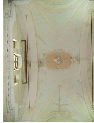
Intradosso della volta O13, elemento interagente: Facciata V1 [14-05-2012]
