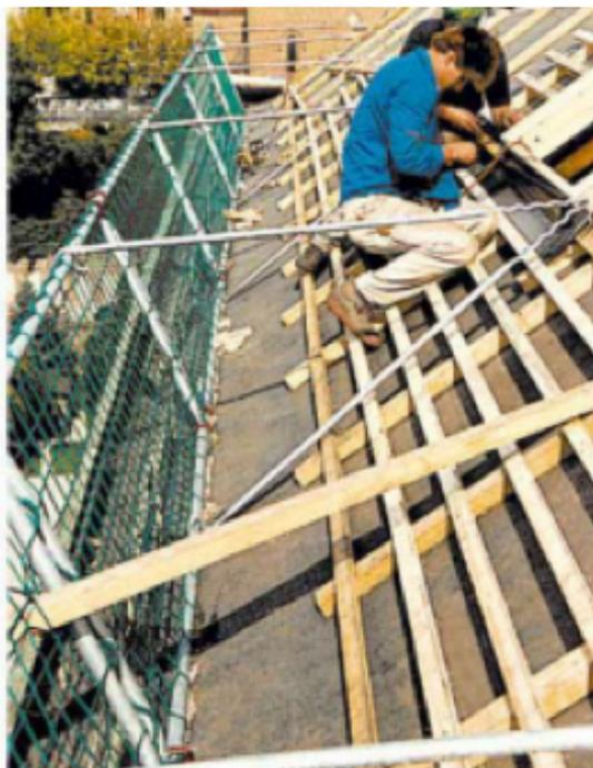
Nei casi di tetti a falda, in relazione al grado di inclinazione della stessa, potrebbe essere indispensabile predisporre passerelle o installare dispositivi di ancoraggio. Inoltre, sempre in relazione al grado di inclinazione, dovrà essere valutato se è opportuno predisporre un parapetto “pieno”.
