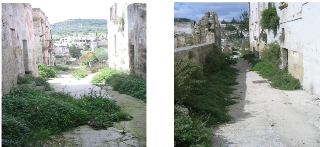
Figura 3-70 immagine dissesti viari in via Piaggio e via Scalette
