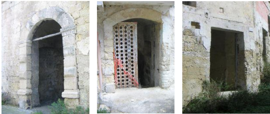
Figura 3-79 Immagini aperture e ingressi nel Rione Piaggio
