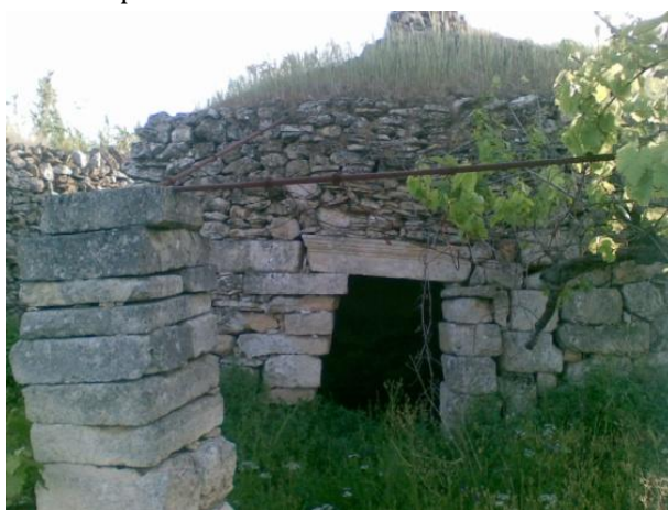
Figura 3-14 Immagine del Pacro Archeologico di Petramagna. Lamia ottenuta da materiali di risulta delle mura dell'antica Silbion
