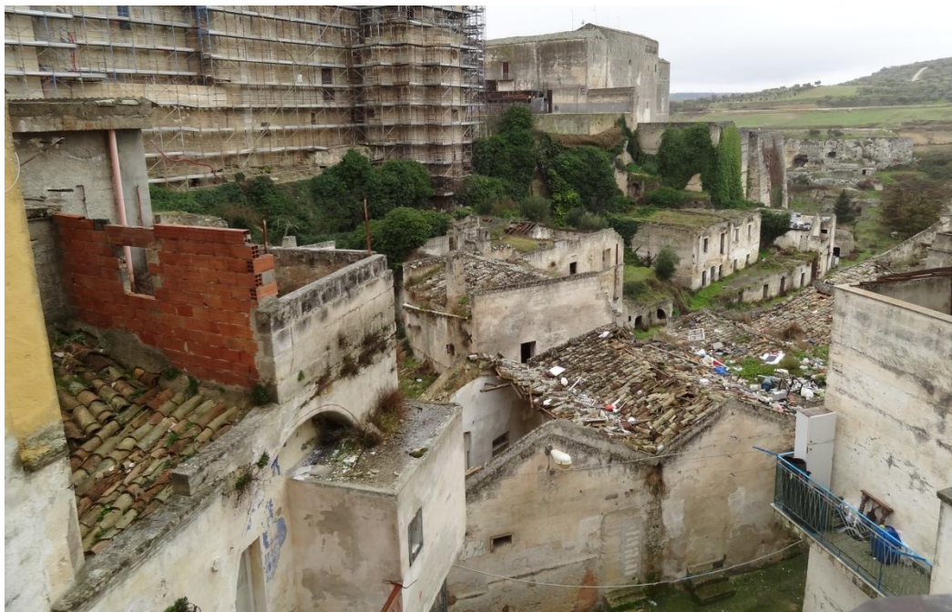
Figura 3-36 Immagine del degrado allo stato attuale nel Rione Piaggio di Gravina in Puglia
