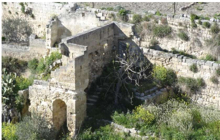
Figura 3-73 Immagini fondazioni e muri di elevazione in via Piaggio
