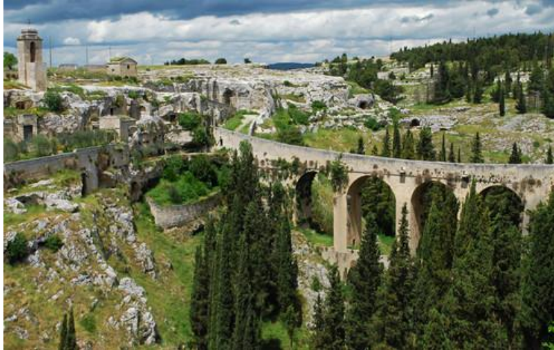
Figura 3-28 Immagine del Ponte – Acquedotto che unisce le due sponde della Gravina
