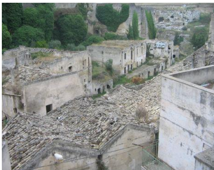
Figura 3-77 Immagine coperture in via Scalette
