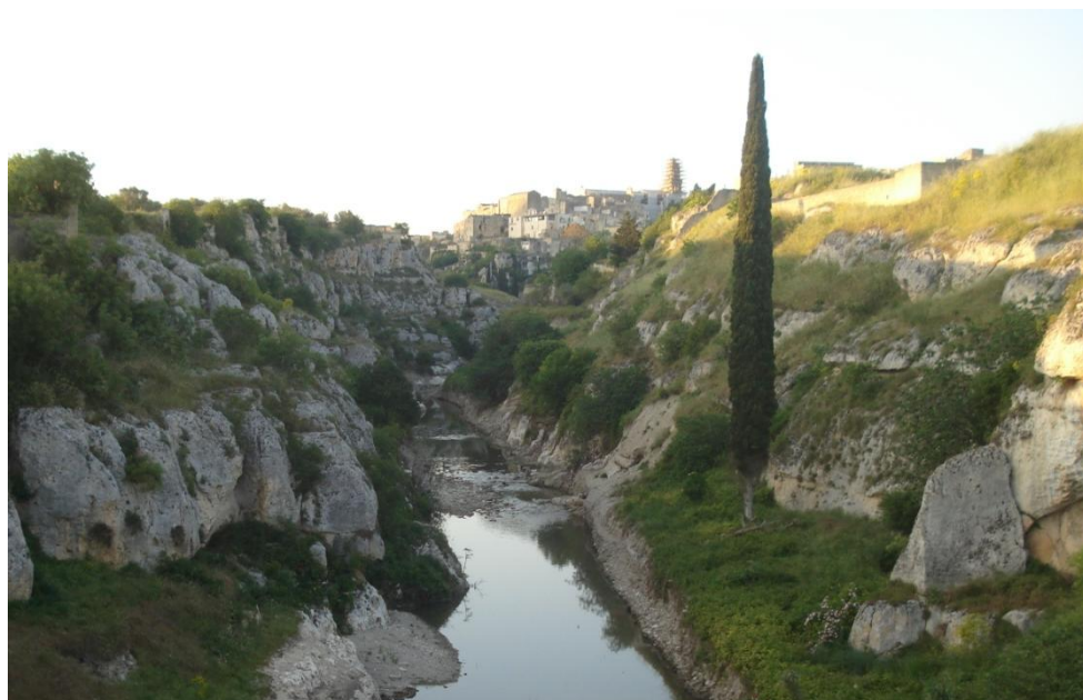
Figura 3-13 Immagine del torrente Canapro in zona sud-ovest di Gravina
