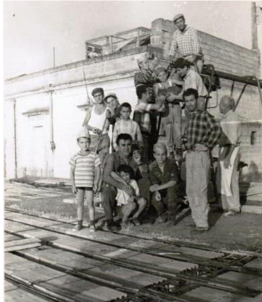
Figura 3-35 Immagine di un cantiere edile degli anni '50 a Gravina
