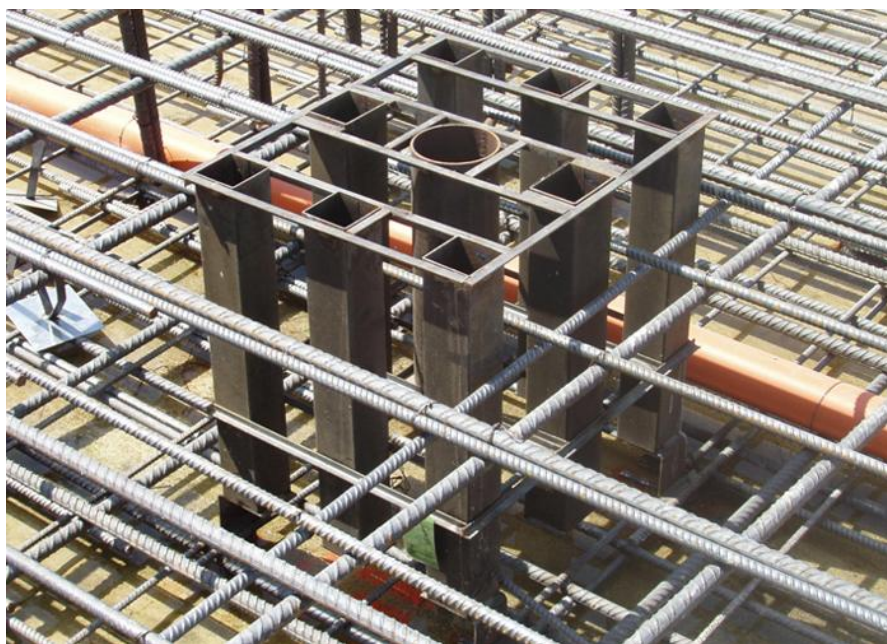
Figura 1.21 Particolare dell'elemento scatolare inserito in una fondazione gettata in opera per l'alloggiamento della pilastro prefabbricata [www.ape.it]
