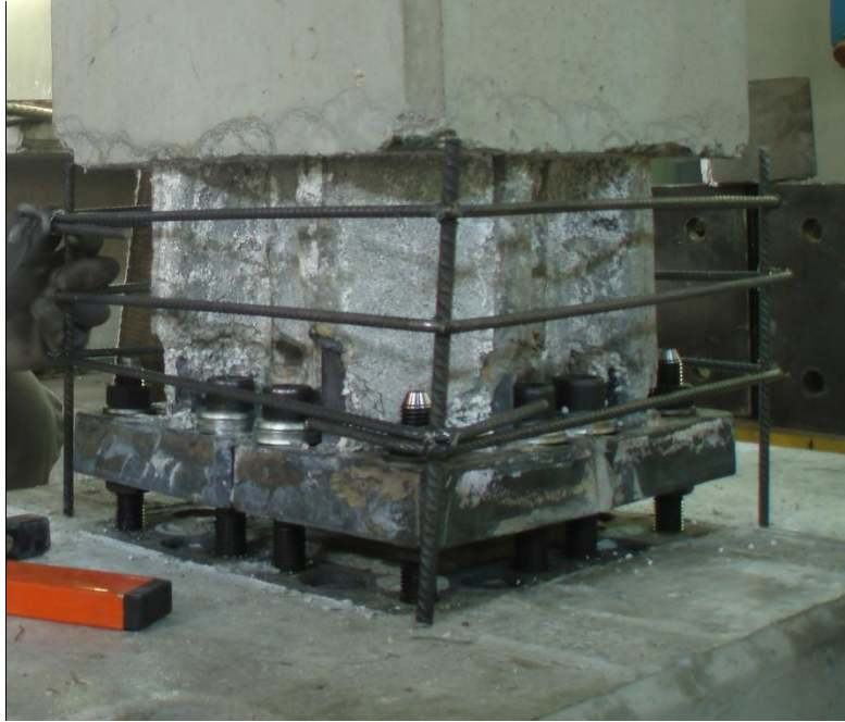
Figura 1.26 Esempio di armatura della pilastro prima del getto, in evidenza le 4 piastre angolari con i 3 fori per le viti di ancoraggio e le barre ad aderenza migliorata
