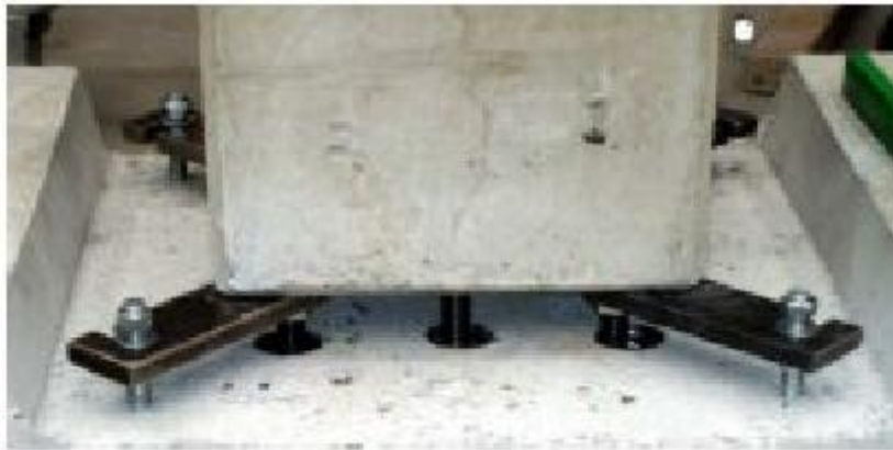
Figura 1.32 Montaggio del pilastro con le piastre di regolazione poste negli angoli. (Metelli, Riva, 2008 [23])
