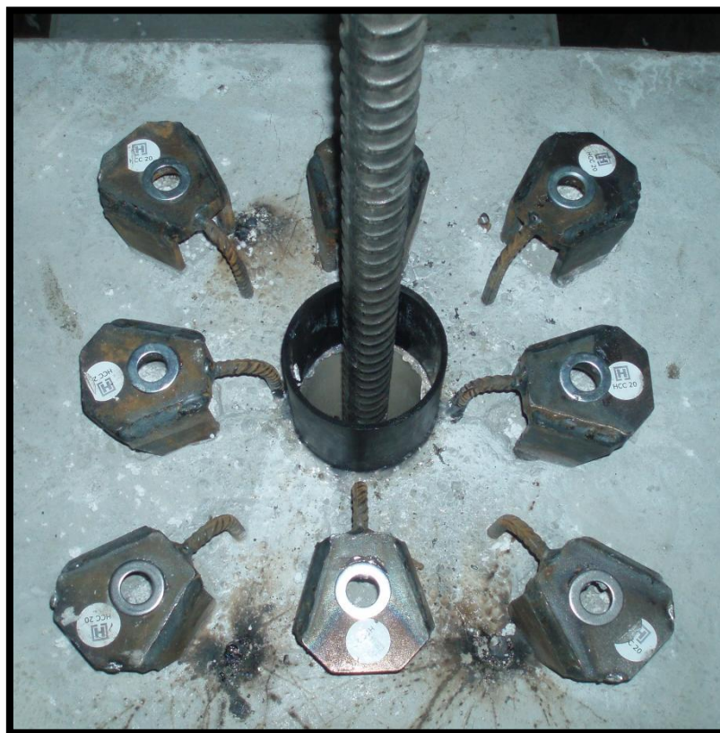
Figura 2.38 Particolare della fondazione con le scarpe invertite
