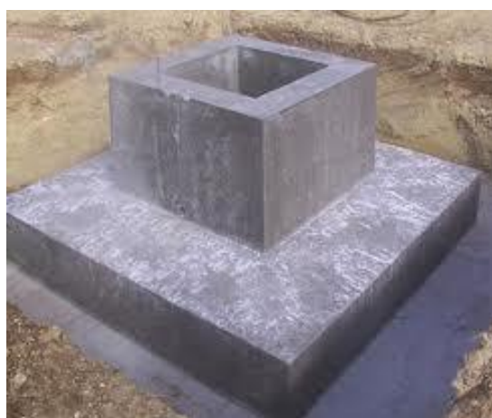
Figura 1.19 a) Particolare dell'infissione del pilastro prefabbricato nel plinto b) Plinto prefabbricato a base quadrata [www.sicemspa.net]
