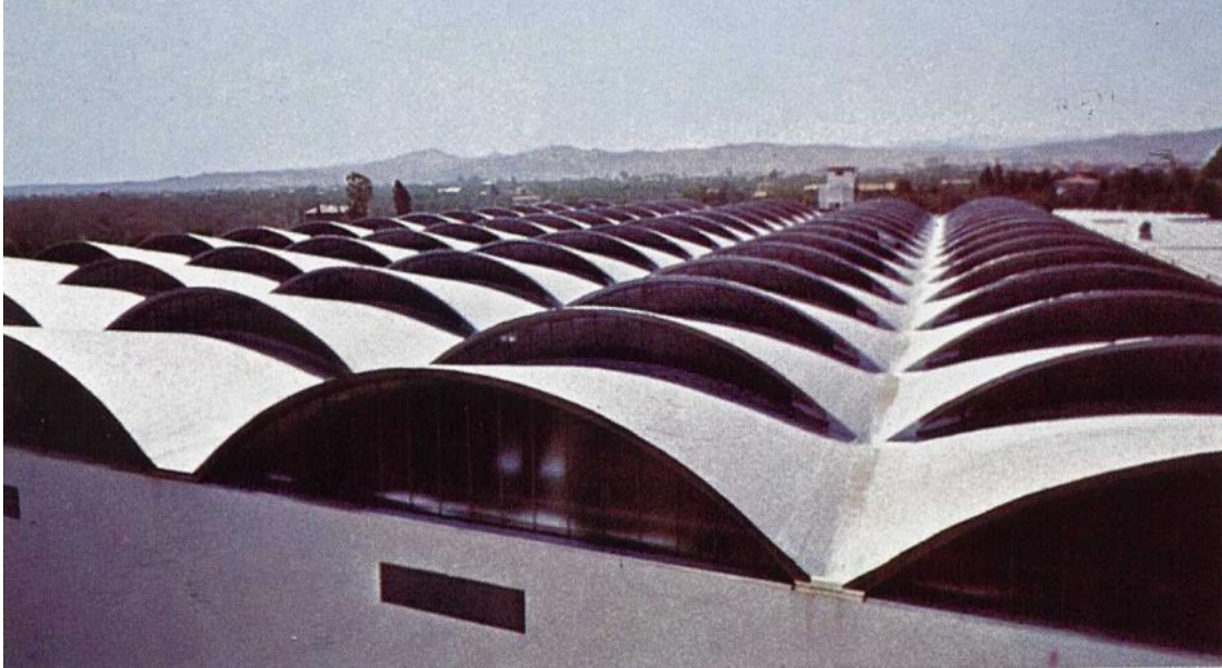
Figura 1.1 Copertura con volte a shed in latero-cemento. (Toniolo,2000[6])
