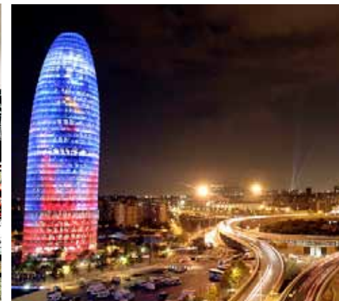
Fig.11.15 Riferimenti, Torre Agbar, Barcellona
