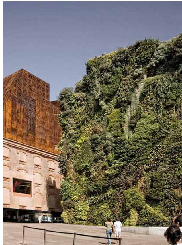
Fig.12.57 CaixaForum Madrid_Herzog & de Meuron_2008
