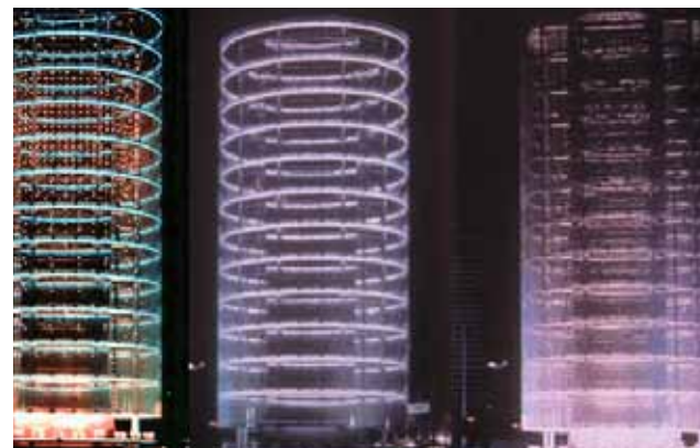
Fig.12.153 Torre dei Venti_Toyo Ito_2008
