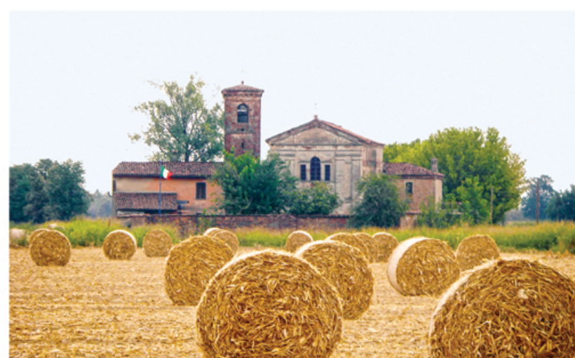
Prospetto ovest della chiesa e del compendio di Santa Maria della Senigola
