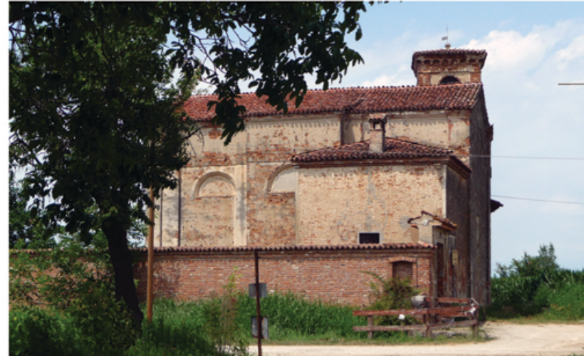
Prospetto sud della chiesa e del compendio di Santa Maria della Senigola
