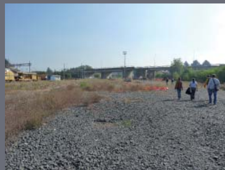
Fig. 8 Il viadotto sulla ferrovia
